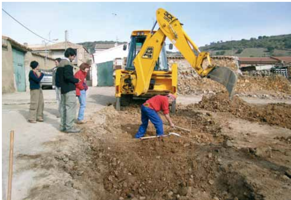
Trabajos de excavación.
