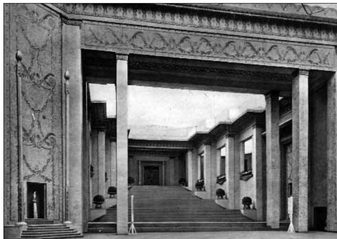
Fig. 5. Charles Letrosne. Interior del Grand Palais.
