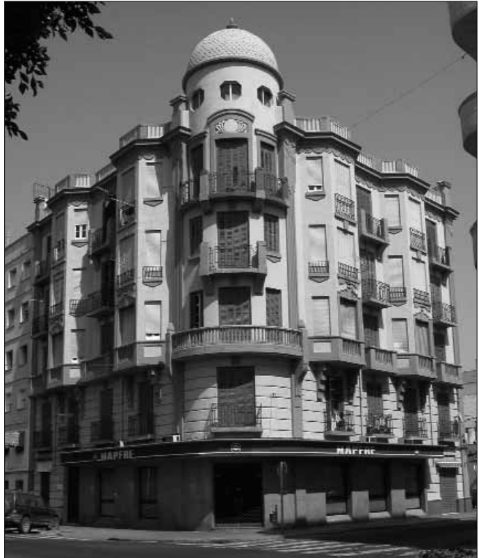
Fig. 7. Edificio en la avenida de la Democracia. Arquitecto Enrique Nieto Nieto, 1934-1935.
