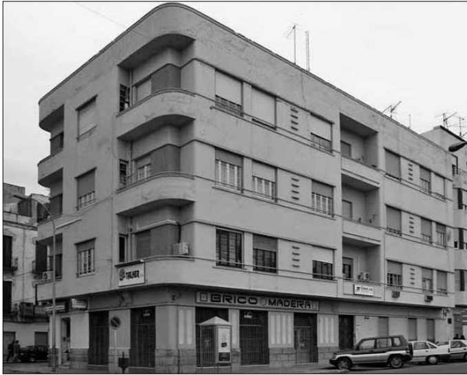
Fig. 14. Edificio en la avenida de la Democracia, 9. Arquitecto Francisco Hernanz Martínez, 1934.
