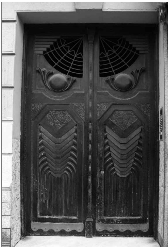
Fig 21. Puerta en un edificio de la avenida de la Democracia. Arquitecto Enrique Nieto Nieto, 1934-1935.
