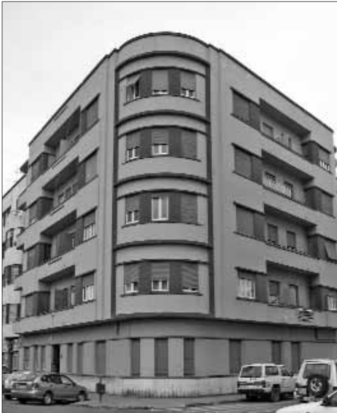
Fig. 15. Edificio en la avenida de la Democracia, 11. Arquitecto Francisco Hernanz Martínez, 1935.
