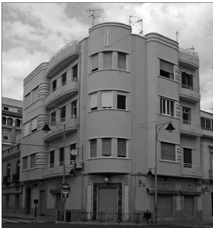
Fig. 19. Edificio en la calle Sidi Abdelkader, 6. Arquitecto Francisco Hernanz Martínez, 1936.
