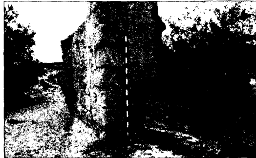
FIGURA 11: Puente del Alberche: vista frontal del contratajamar triangular. (Foto: C. Pacheco.)
