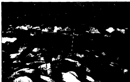
FIGURA 2: Puente Viejo: Detalle del aparejo de sillería romana bajo la obra medieval. (Foto: C. Pacheco.)
