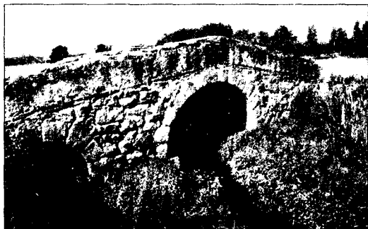
FIGURA 14: Cara sur del puente sobre el arroyo Barrago (Talavera). (Foto: C.Pacheco.)
