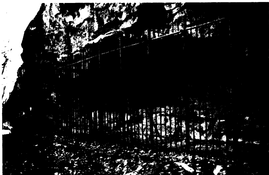
Figura 4. Vistas de El Mirador antes (verano de 1980) y después (otoño de 1981) de la colocación de sus verjas protectoras (Fotografías de J.J. Ruiz Ezquerro y Juan A. Gómez-Barrera).
