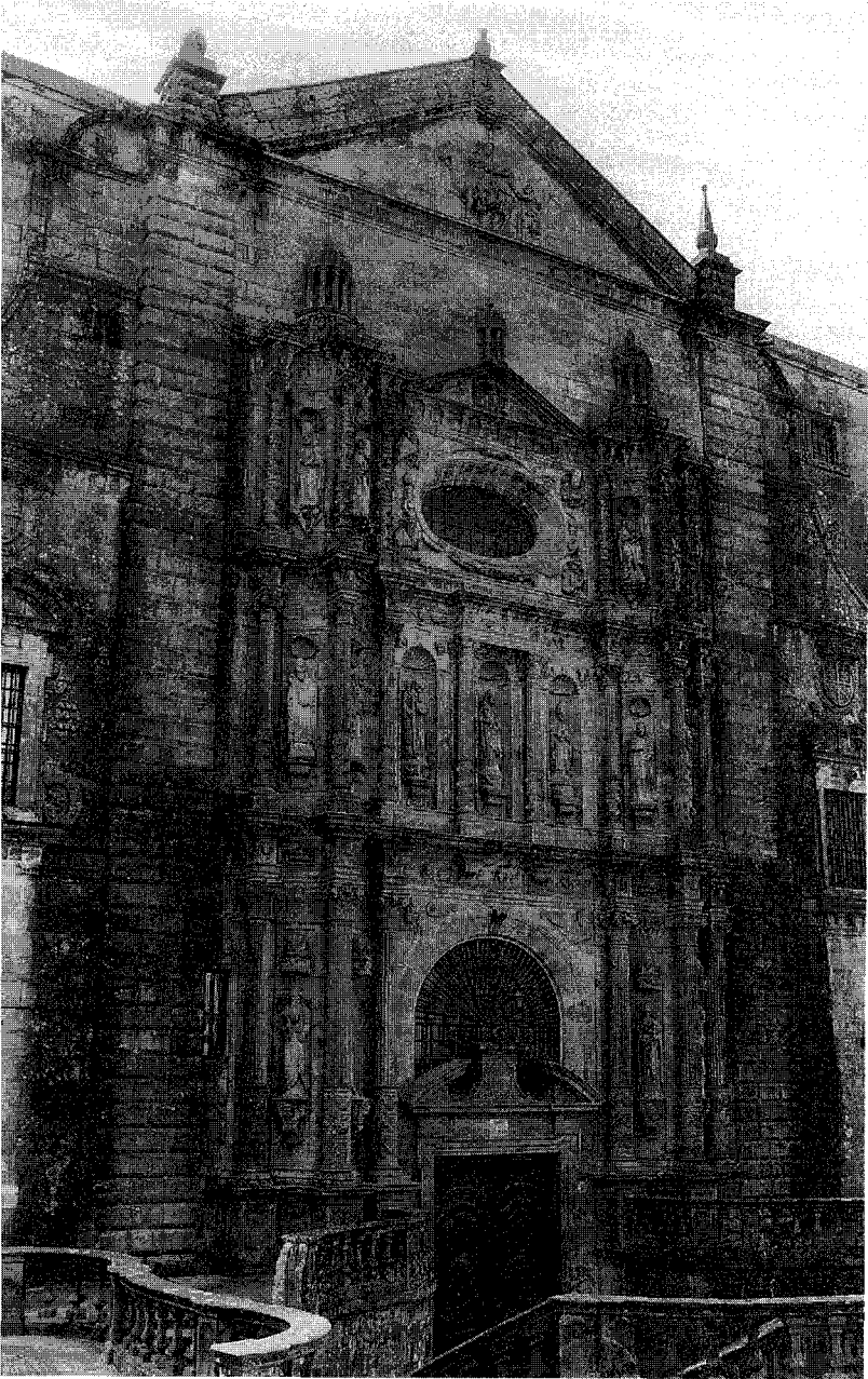
Fig. 7. La fachada de la Iglesia de San Martín Pinario.
