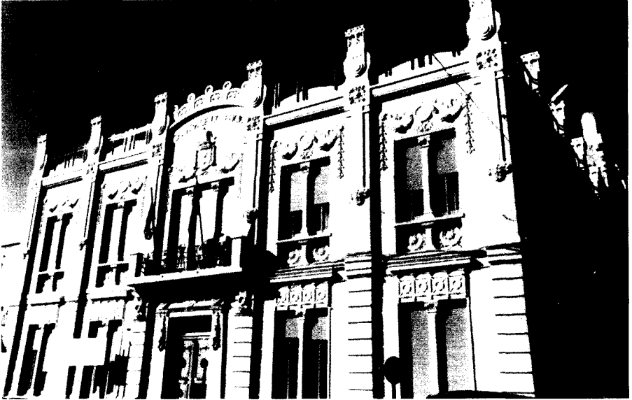
Lám. 1. Cámara Oficial de Comercio (1913-1915). C/ Cervantes, 7. Fachada.
