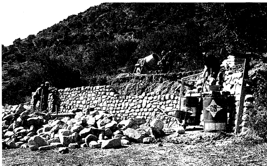
Fig. 8. Construcción de muros de mampuesto tradicional en colaboración con ICONA. Año 1977.
