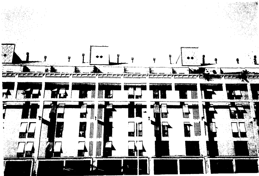
Fig. 12. «Mansardas disimuladas con tablero» (La Remonta).
