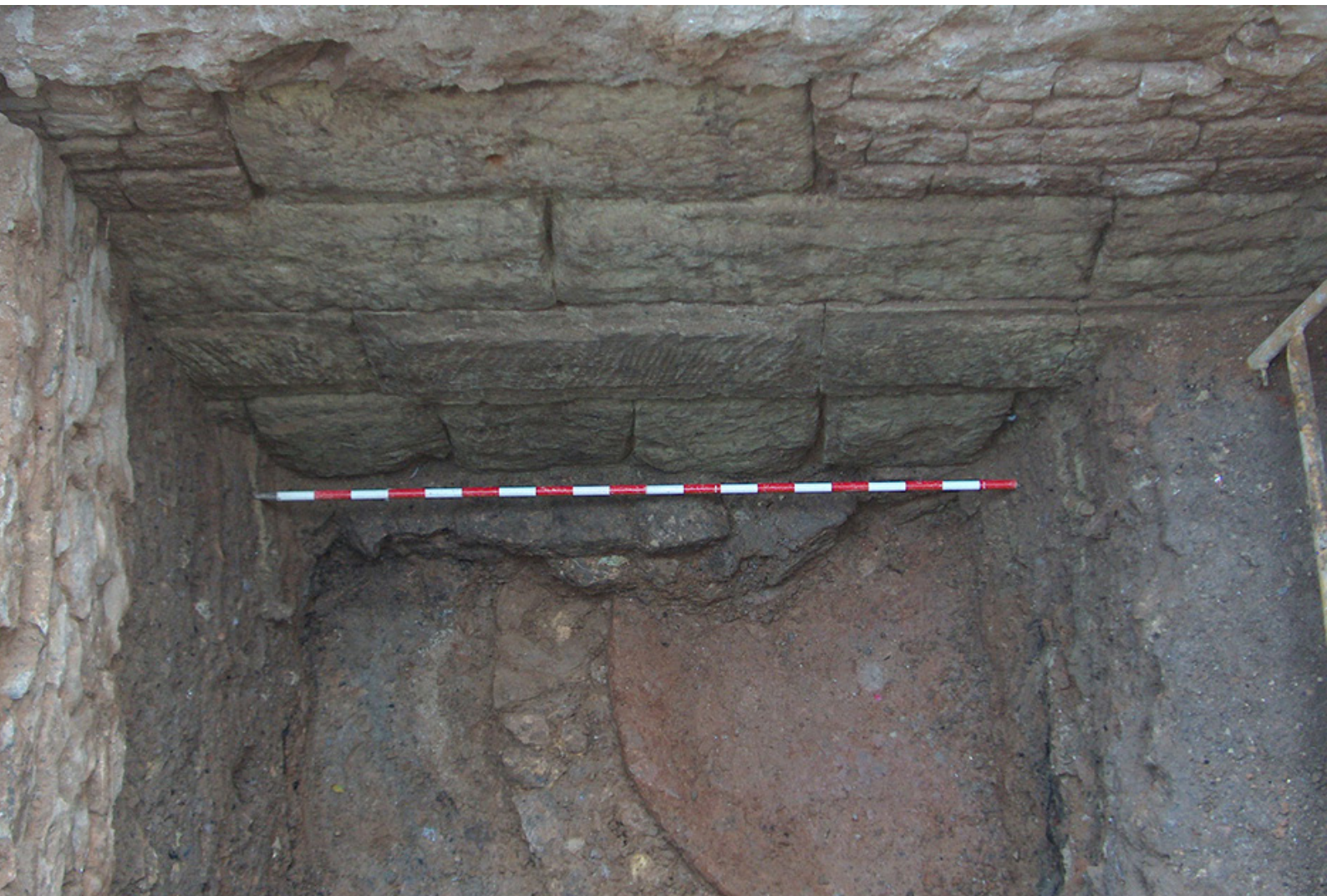
FIGURA 1.- MURO DE ATERRAZAMIENTO PÚNICO DE LA CALLE PALAS, N.º 5-7, CONSTRUIDO CON APAREJO EN DAMERO Y OPUS QUADRATUM , SUPERPUESTO A ESTRUCTURAS INDÍGENAS AMORTIZADAS (FOT. J. A. ANTOLINOS).
