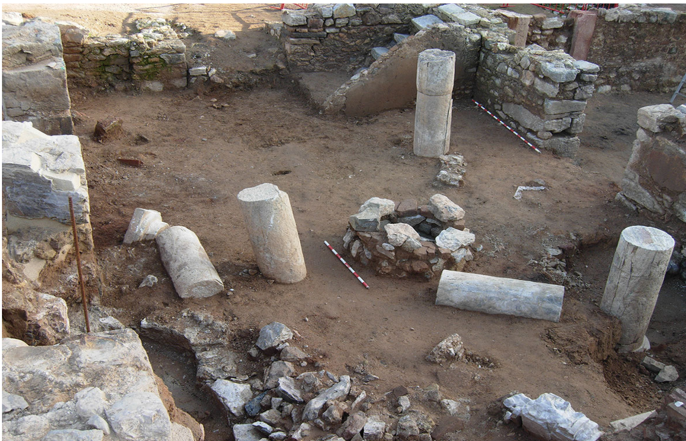
FIGURA 12. ATRIO COLAPSADO DEL EDIFICIO DEL ATRIO (INSULA I DEL MOLINETE) EN EL SIGLO V, CON PUTEAL DEL POZO CENTRAL RECRECIDO CON PIEDRAS (FOT. EQUIPO MOLINETE).
