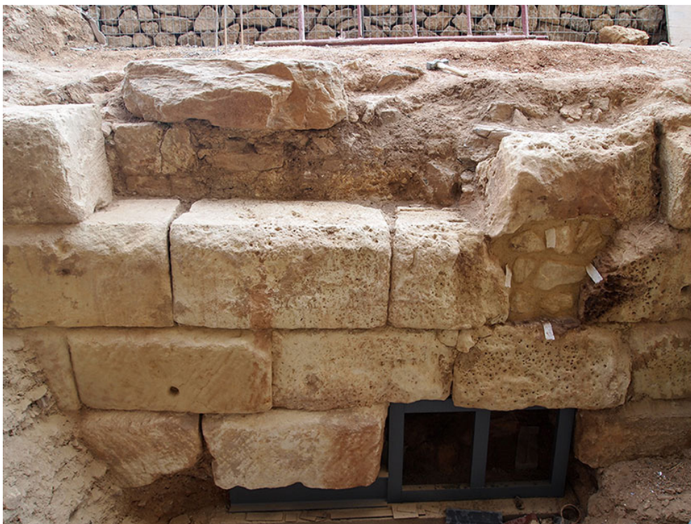
FIGURA 6.- DETALLE DEL MURO DE ATERRAZAMIENTO DE SILLARES DE ARENISCA, CONSTRUIDO EN EL SIGLO I a.C. AL NORTE DE UNA CALLE DE TIERRA ORIENTADA ESTE-OESTE EN LA LADERA SURESTE DEL CERRO DEL MOLINETE (FOT. M. a J. MADRID).
