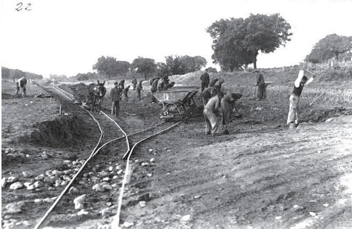
Figura 4. Presos de la Brigada de Tierras picado en el tajo del canal.
