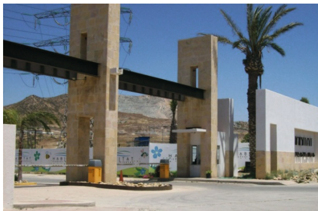
▲ FIGURA 13. Residencial Habitat Piedras Blancas (Zona Sureste).
