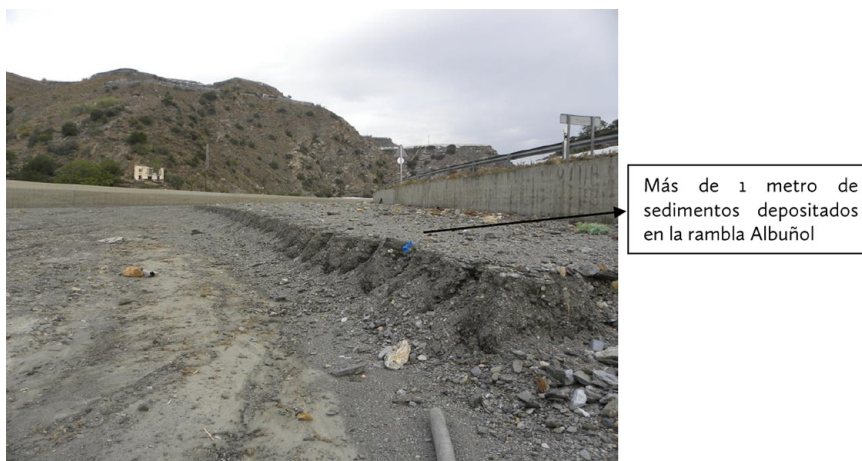
IMAGEN NÚMERO 8.- FOTO CAPTADA DESDE EL INTERIOR DEL CAUCE DE LA RAMBLA. SE APRECIA COMO LA INERCIA DE LA VELOCIDAD DEL AGUA SE CIÑÓ SOBRE EL MARGEN DERECHO DEL CAUCE, SOBREPASANDO EL MURO DE CONTENCIÓN (4 METROS), DEPOSITANDO TONELADAS DE SEDIMENTOS EN EL MARGEN IZQUIERDO, QUE SUPERAN EL METRO DE ALTURA. Autor: José Ramón Sánchez Holgado.
