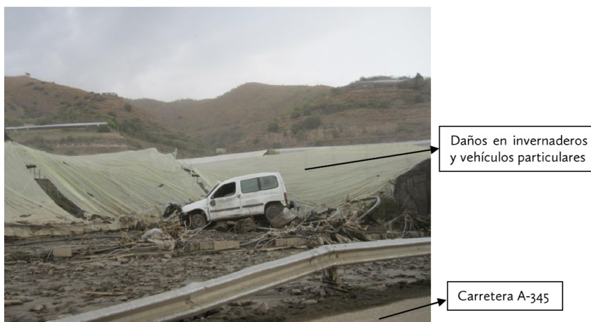
IMAGEN NÚMERO 15.- DAÑOS EN INVERNADEROS. Autor: José Ramón Sánchez Holgado.
