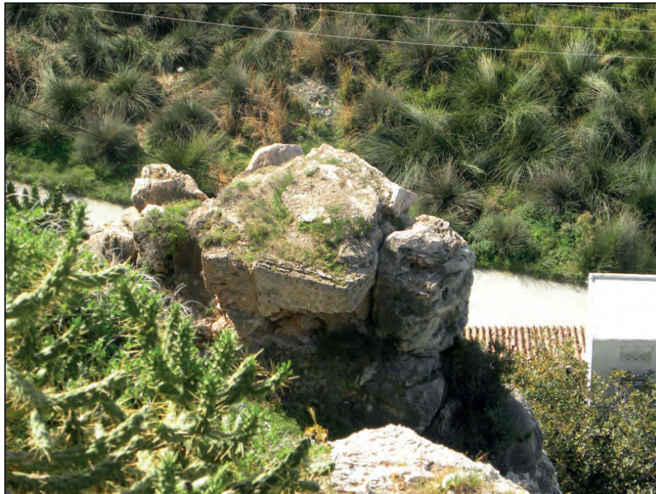
FIGURA NÚMERO 21.- RESTOS DE UNA ANTIGUA TORRE, DE AL MENOS DOS EXISTENTES, QUE CUSTODIABA LA LLEGADA DE EMBARCACIONES Y EL ACCESO AL CAMINO DEL CASTILLO. Autor: José Ramón Sánchez Holgado.
