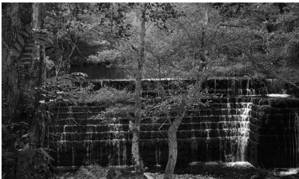
FOTO 2. Dique de la presa en el río Xunco que daba energía hidráulica a la factoría. Levantada en 1791 y reformada a mediados del siglo XIX. La toma del canal se encuentra a la izquierda de la imagen, oculta tras el árbol.
