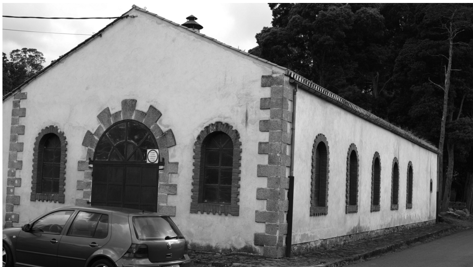
FOTO 8. Vista general del taller mecánico, levantado entre 1846 y 1849 aproximadamente. Representante de la última fase constructiva de Sargadelos, en él se construyeron dos máquinas de vapor para la propia empresa.
