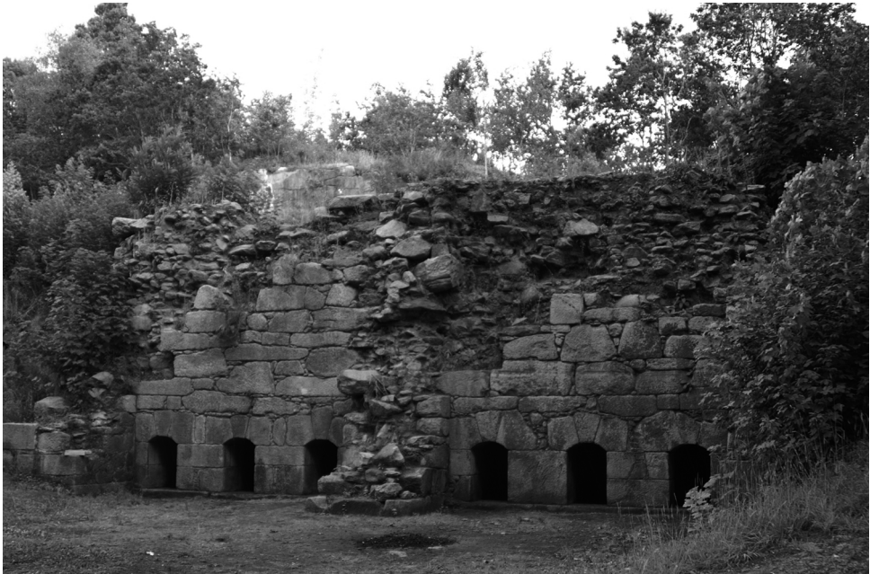
FOTO 3. Ruinas de los hornos de calcinación, realizados durante la etapa de Luis de la Riva, antes de 1849.
