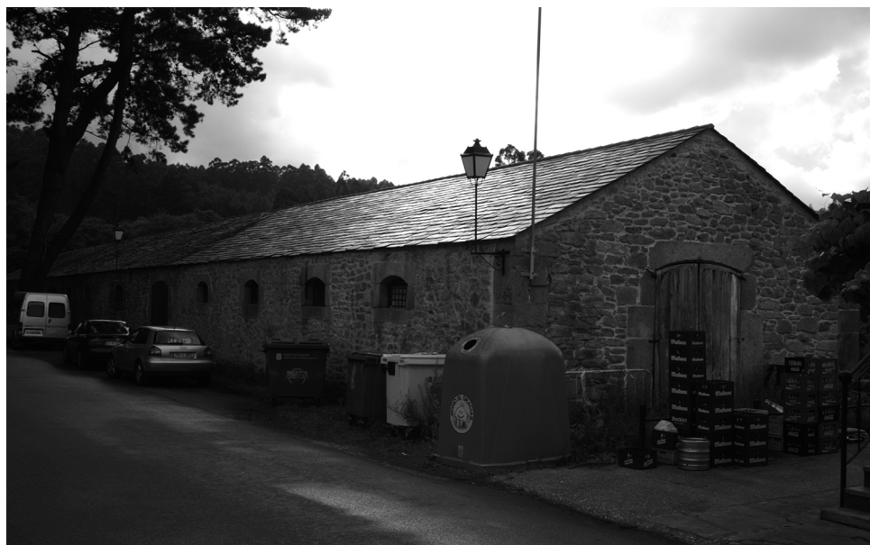
FOTO 6. Almacén para productos terminados. Se sitúa en la zona norte de la fábrica y data de la primera fundación de 1791. Parece que en los primeros momentos se utilizó también como vivienda para operarios.
