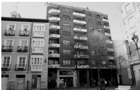
Figura 9. Dos generaciones de sustituciones en el casco histórico de Valladolid (Plaza del Salvador): a la izquierda, la más reciente, conserva la fachada. A la derecha, un ejemplo típico de sustitución con retranqueo y elevación de alturas y volumen edificado de los años 1960-1970.
