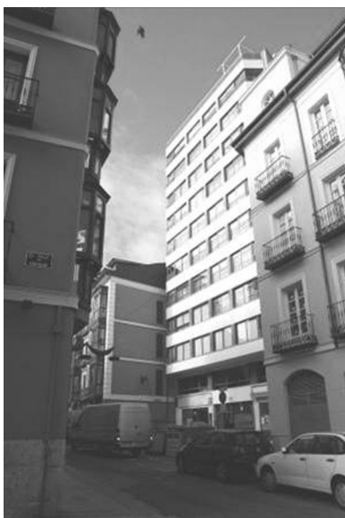
Figura 7. Ejemplo de la brutalidad de la expresión de la arquitectura contemporánea en las sustituciones efectuadas hacia las décadas de 1960 y 1970 en algunos cascos históricos (calle Regalado, Valladolid).
