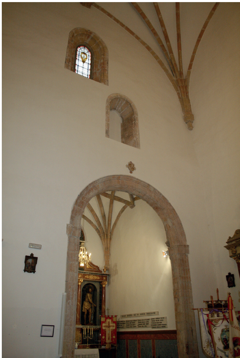
FIGURA 2. PARROQUIA DE VILLANUEVA DE ALCARDETE. MURO DEL PRIMER TRAMO DE LA NAVE DEL EVANGELIO CON LA VENTANA TAPIADA.
