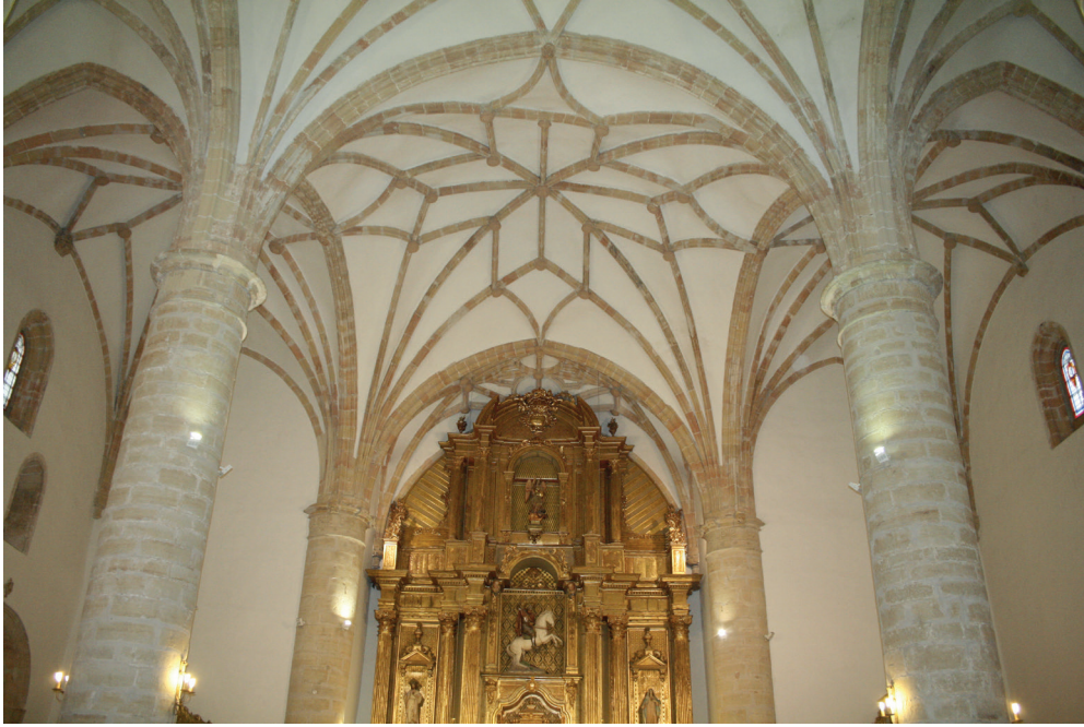
FIGURA 5. PARROQUIA DE VILLANUEVA DE ALCARDETE. BÓVEDAS DEL CRUCERO.
