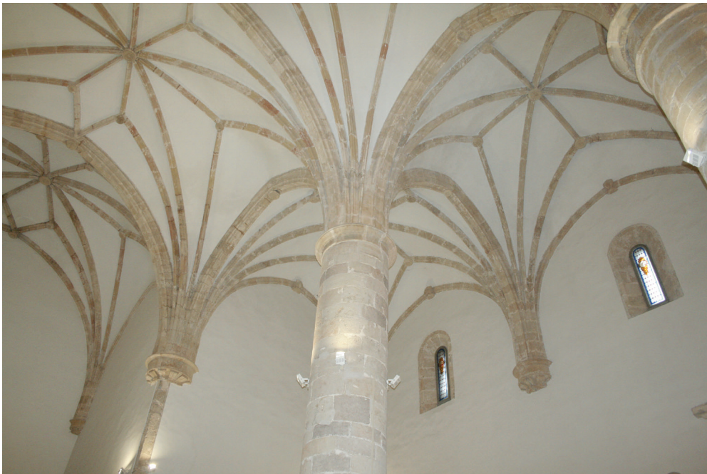
FIGURA 6. PARROQUIA DE VILLANUEVA DE ALCARDETE. MÉNSULAS DE LOS MUROS DE LA IGLESIA.
