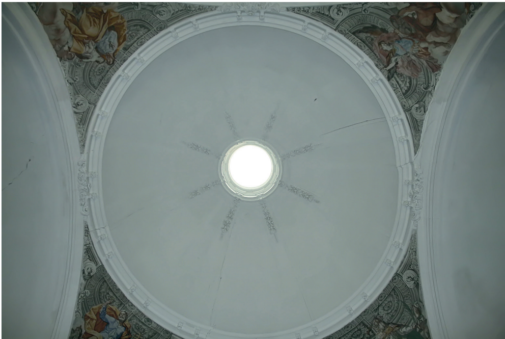
FIGURA 12. PARROQUIA DE DOSBARRIOS. CÚPULA.
