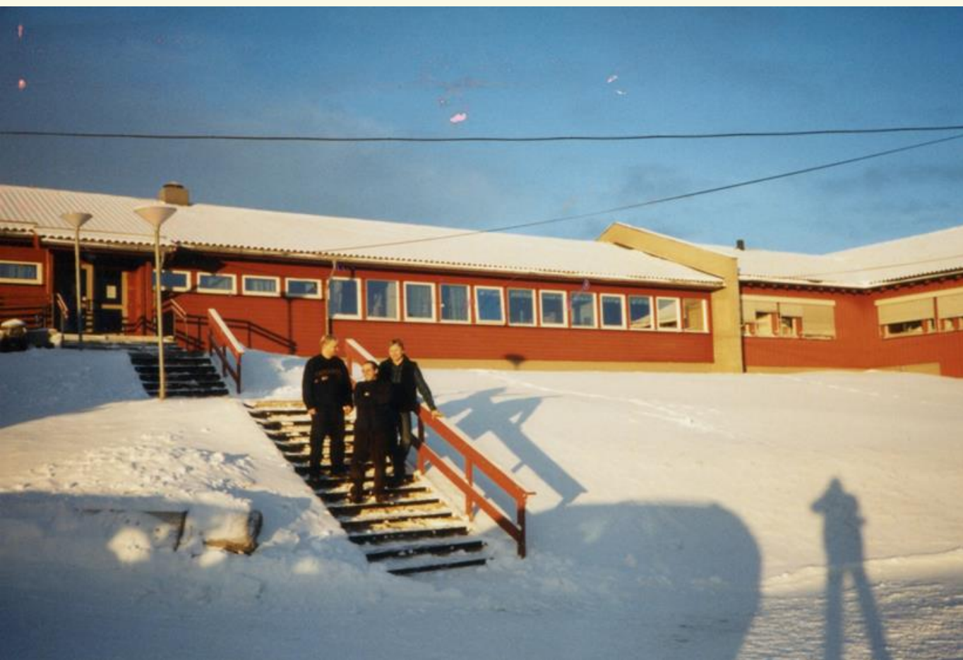
Primer edificio de la Escuela Sami de Estudios Superiores en 2003: unas viejas instalaciones del ejército.
