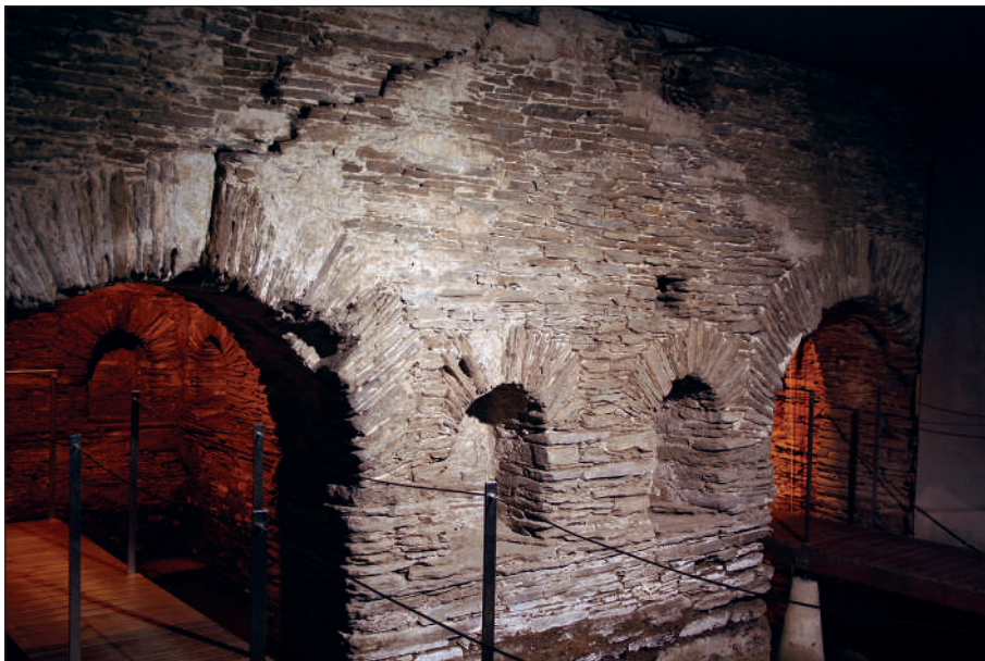
■ Figura 14. Imagen de los restos del balneario romano de Lugo.
