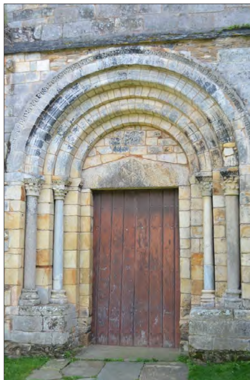
FIGURA 6. VISTA DE LA FACHADA PRINCIPAL DE SAN MARTIÑO DE MONDOÑEDO DE FOZ, CON LAS DOS COLUMNAS INTERIORES EN MÁRMOL Y FORMADAS POR FUSTES DE DISTINTO TAMAÑO REUTILIZADOS. (Foto: UEA/ICAC)
