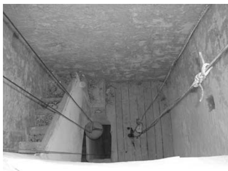
Figura 11. ALMINAR DE BENAOCÁZ. ESCALERA. SE APRECIA LA AUSENCIA DE MACHÓN CENTRAL.
