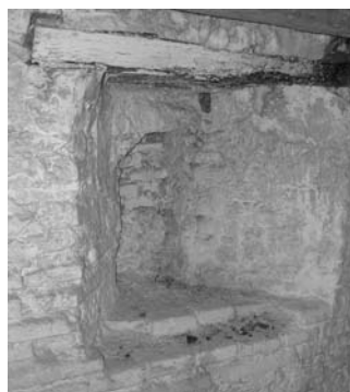
Figura 12. ALMINAR DE BENAOCÁZ. VANO CEGADO, APRECIABLE SÓLO EN EL INTERIOR DE LA FÁBRICA.
