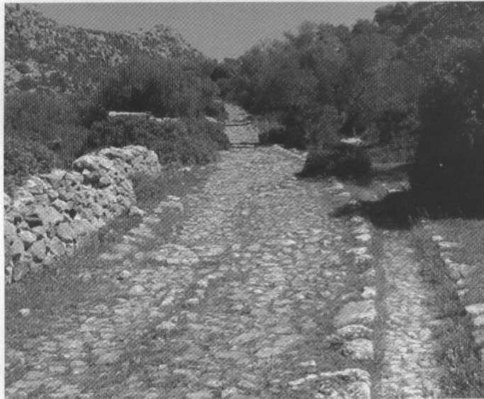
Tramo de la calzada de Ubrique a Benaocaz.
