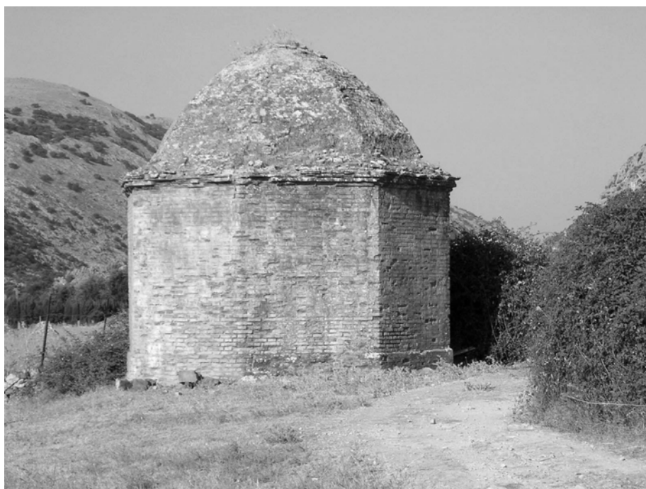
Uno de los pozos principales (C), de planta octogonal, del qanat de Villaluenga del Rosario.
