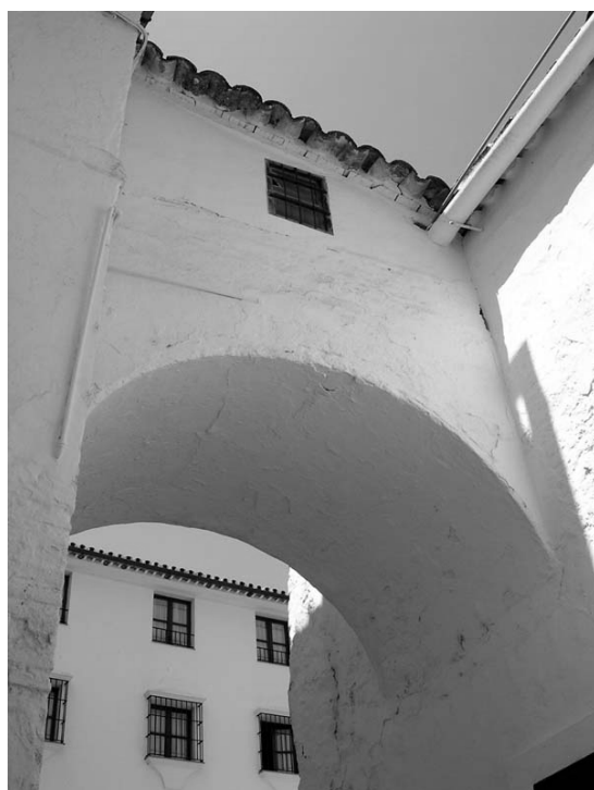
Uno de los arcos que atestiguan actualmente la primitiva situación de la Puerta de la Villa de Grazalema.
