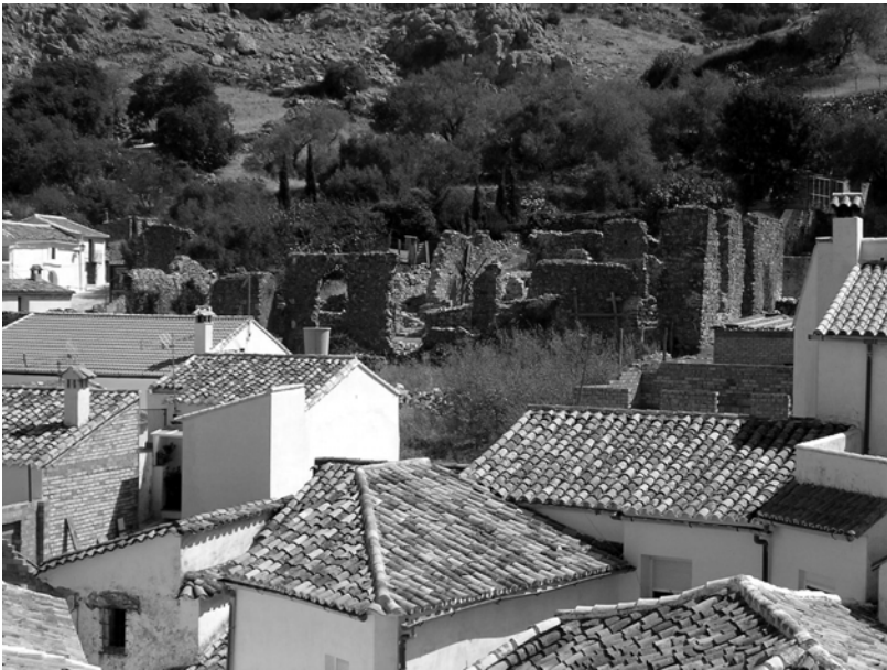
Plano del Barrio Alto nazari de Benaocaz y vista de parte de sus ruinas desde el campanario de San Pedro, antiguo alminar de la mezquita.
