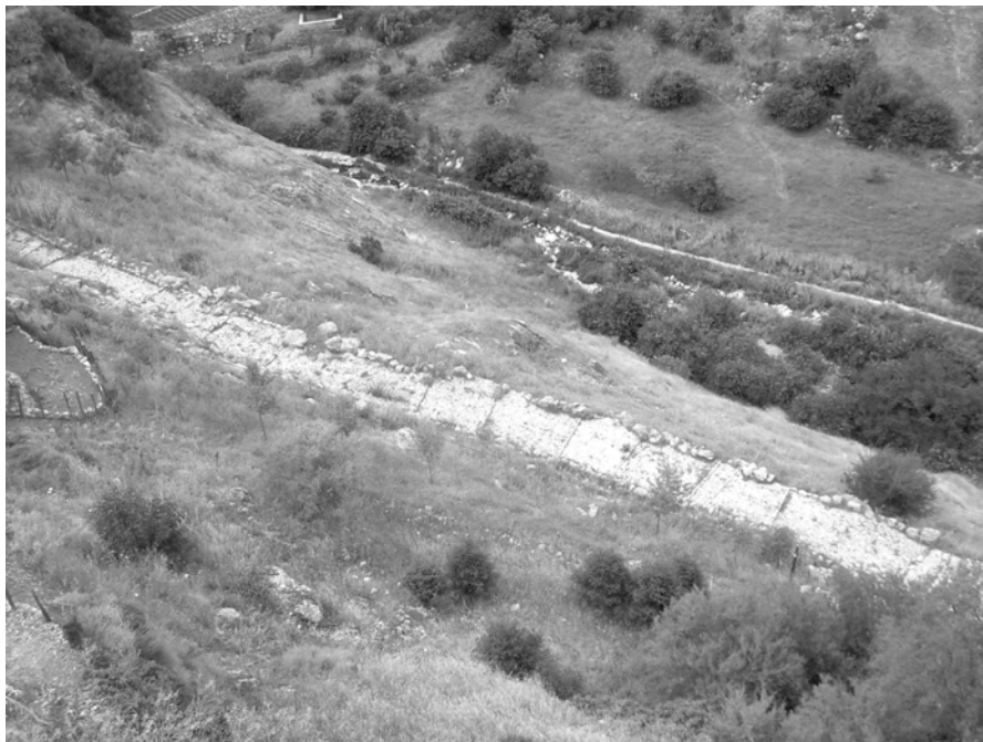
Tramo central de la calzada de Grazalema.
