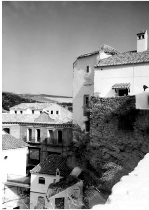
En Setenil, las casas que bordean la Peña se construyeron aprovechando las murallas de la fortaleza.
