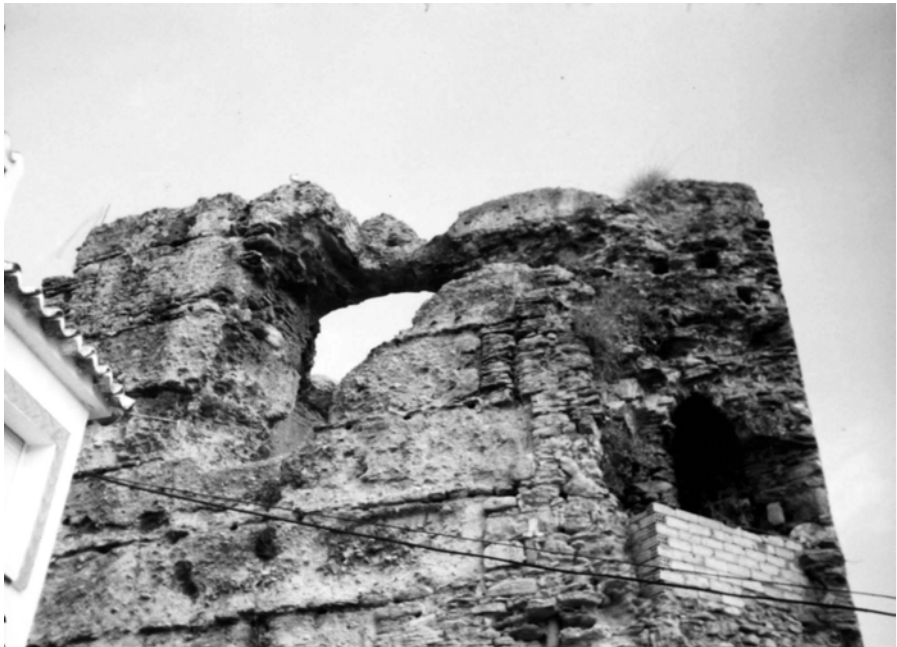
Castillo de Setenil: en la cara SE de la Torre del Homenaje se puede apreciar la combinación de piedra y tapial en su fábrica.
