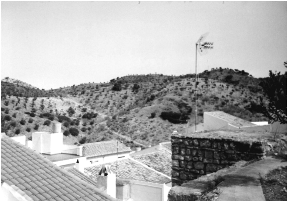
A las murallas del castillo de Alháquime se adosan las viviendas inmediatas del casco urbano de Torre Alháquime, e incluso se aprovechan para instalar cableados y antenas.
