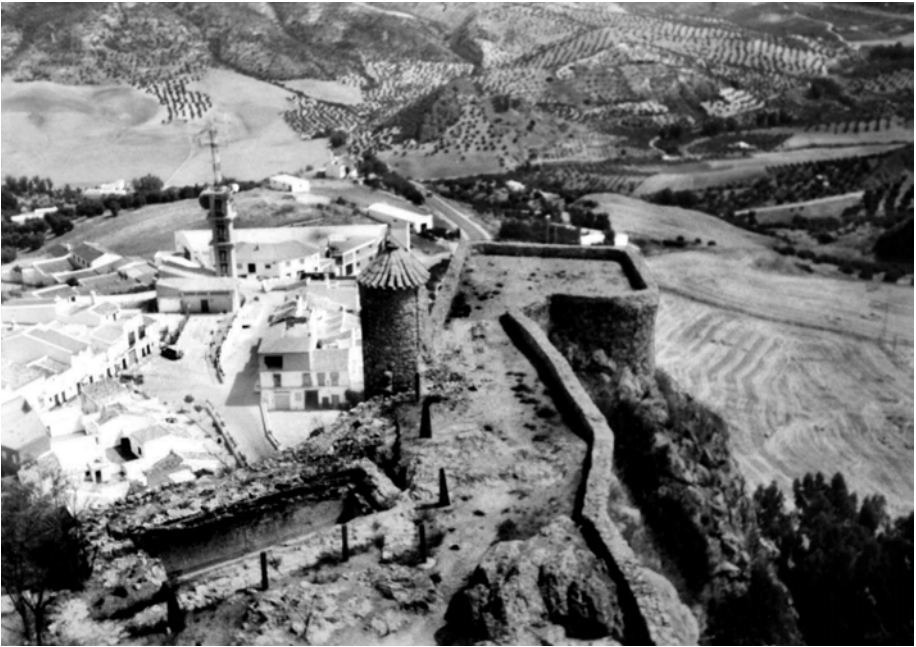
Castillo de Olvera. Aljibe descubierto, cubo cilíndrico y restos de la torre norte desde la Torre del Homenaje.
