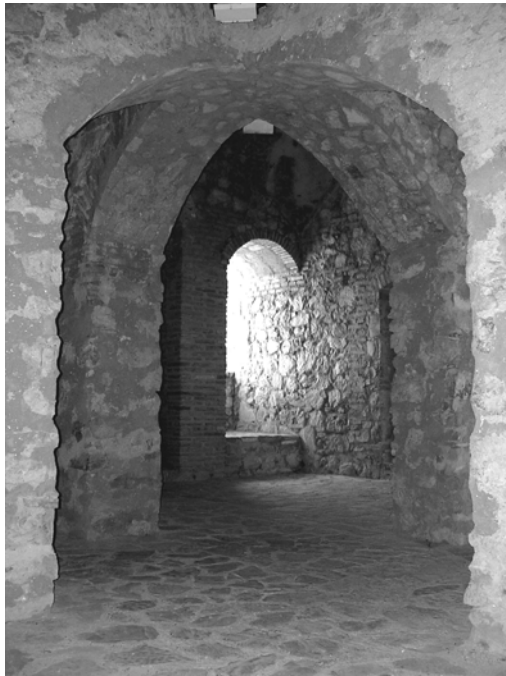
Sala de la primera planta de la Torre del Homenaje de Zahara.
