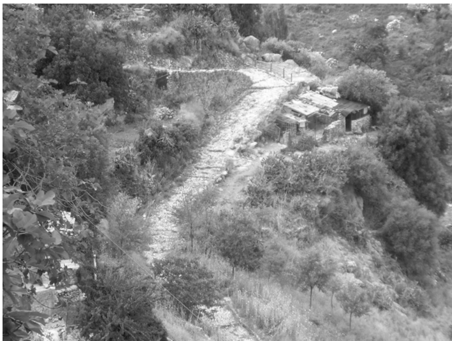
Tramo en curva inmediato al casco urbano grazalemeño.
