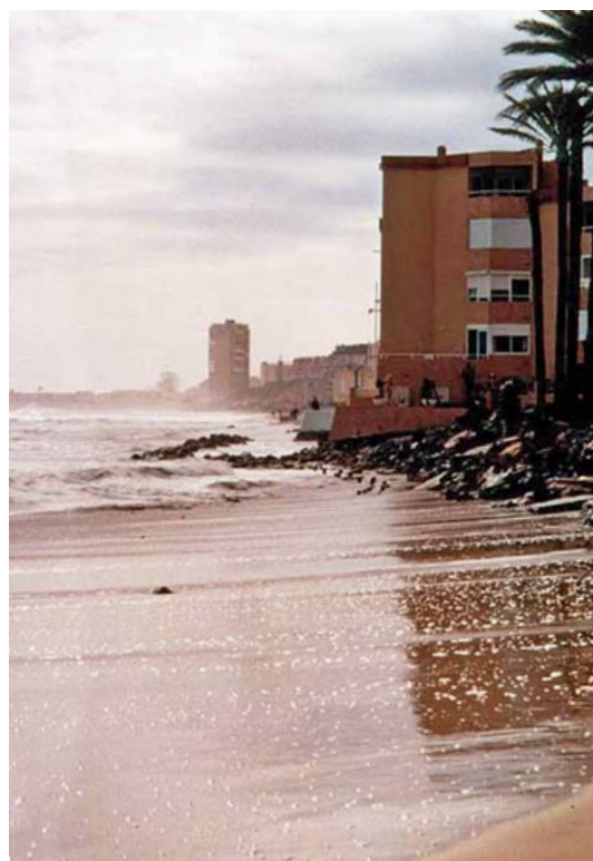
Fig. 13. La Manga del Mar Menor. Erosión y retroceso costero como consecuencia de la alteración antrópica de la dinámica litoral. Frente al edificio en primer plano puede verse una pequeña escollera con fines de defensa.
