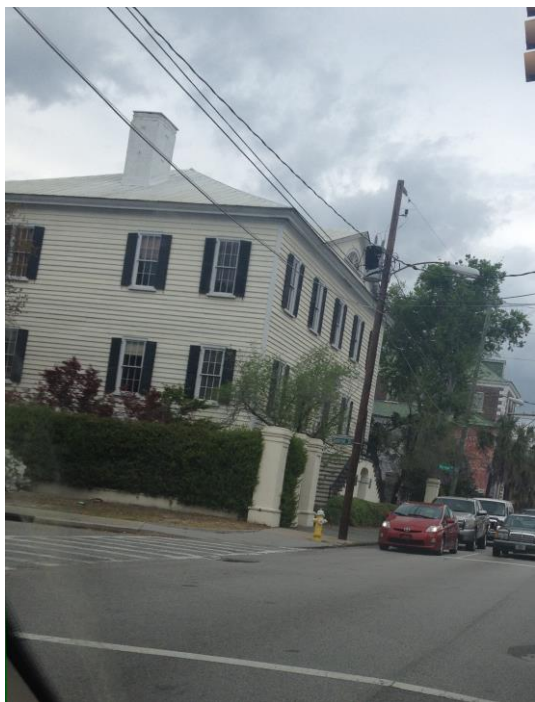
Foto 5 : Vista de la casa situada en el Distrito Histórico de Charleston.
