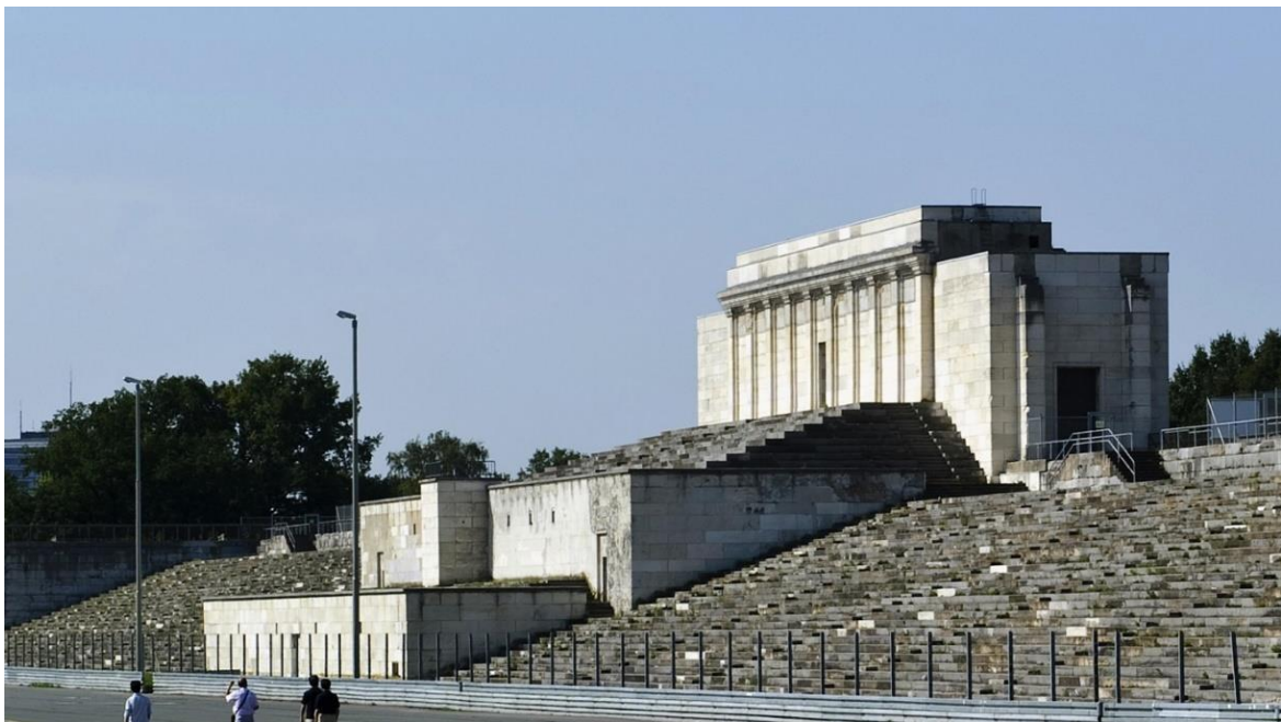
Lo que queda de la edificación en 2021. Imagen tomada de la página oficial de turismo de Núremberg.
