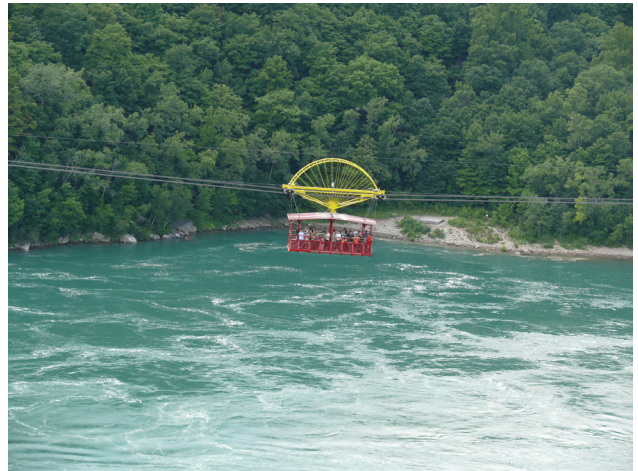
Figura 2. Spanish Aerocar de Leonardo Torres Quevedo construido en 1916 sobre el río Niágara. Fuente: https://es.wikipedia.org/wiki/Spanish_Aerocar .
