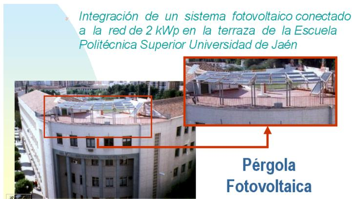
Ilustración 3.- Pérgola fotovoltaica conectada a red en la EPS de Jaén de 2KWp
