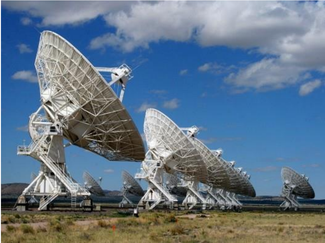
Imagen 1-1: El VLA consta de 27 radio-antenas de 25 metros de diámetro, que mediante la interferometría simulan una antena con una base máxima de 36 Km.
