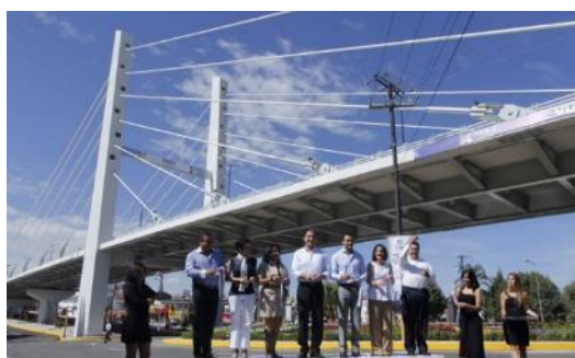
Viaducto Carlos Camacho, Puebla. 170
