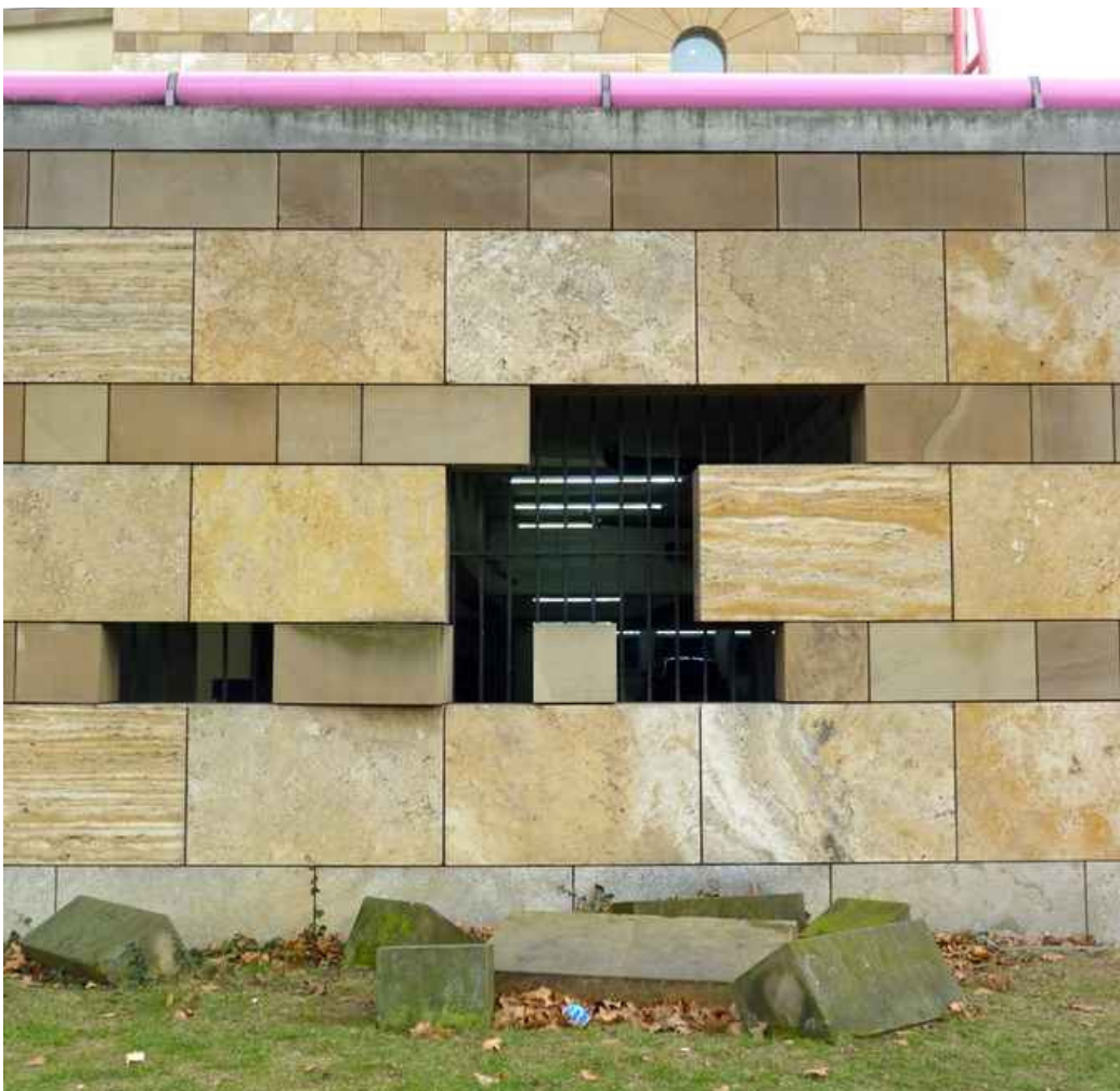
Hueco de ventilación del aparcamiento abierto en el muro de fachada.
