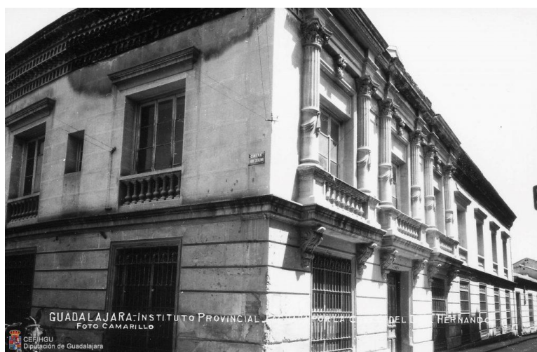
Figura 64. Fachadas laterales, a la calle Museo, del Palacio Antonio de Mendoza o Convento de la Piedad 150 (CEFIHGU- Fondo Camarillo ,1923-1948) 151 .
