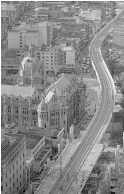
Figura 52. Viaducto del Metro de Medellín a su paso por el centro de la ciudad
