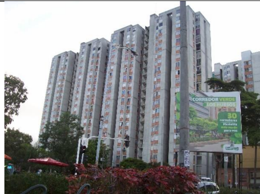
Torres de San Sebastián sobre carrera 46 avenida Oriental
