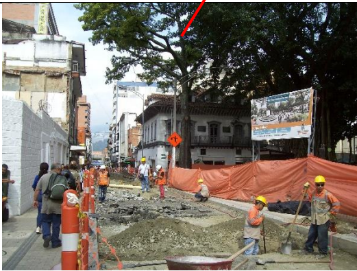
Ejecución de obras en el costado sur del parque de Bolívar
