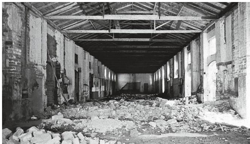
Figura 56. Interior de una de las naves que se sobrevivió a la demolición
