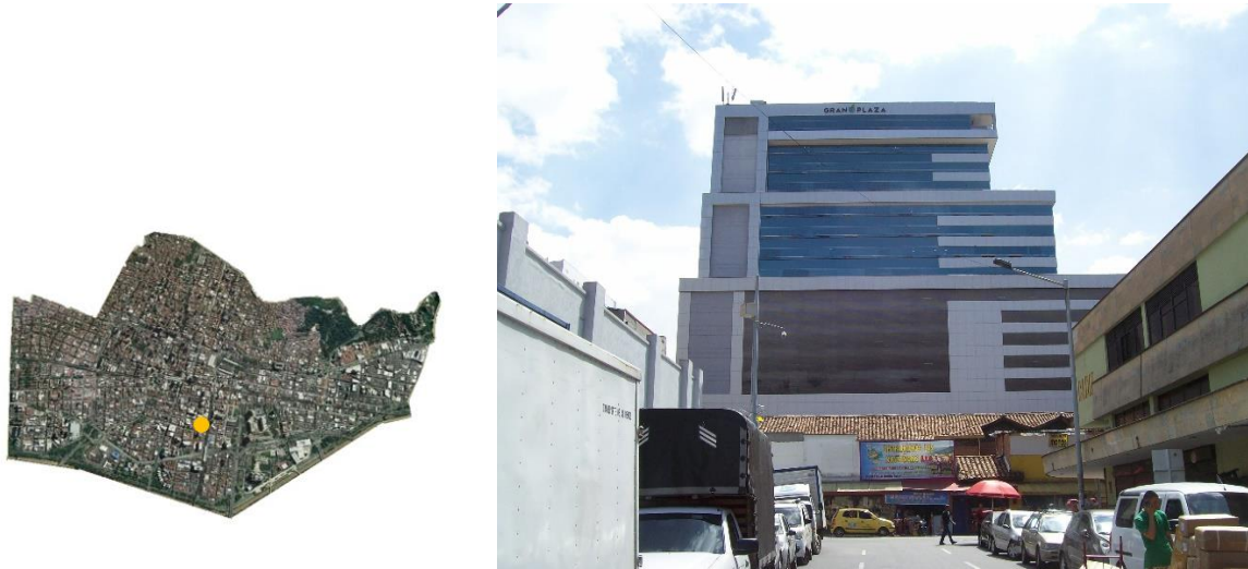
Figura 114. Edificio Gran Plaza sector Guayaquil y ubicación en la comuna 10
