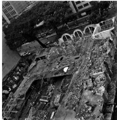
Figura 139. Demolición del Edificio Gonzalo Mejía para la construcción del Edificio Coltejer
