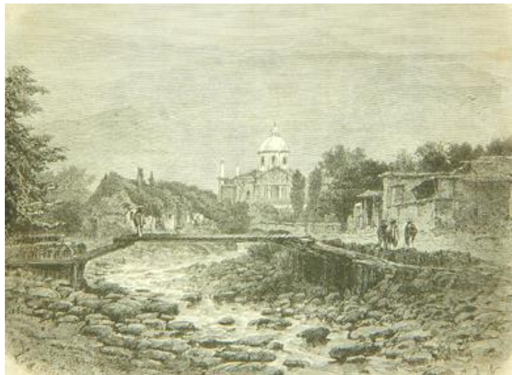
Figura 20. Puente y arrabales en la periferia de Medellín durante el siglo XIX
