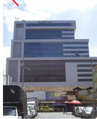
Cruce entre Calle 45 A, con carrera 54 Cúcuta
