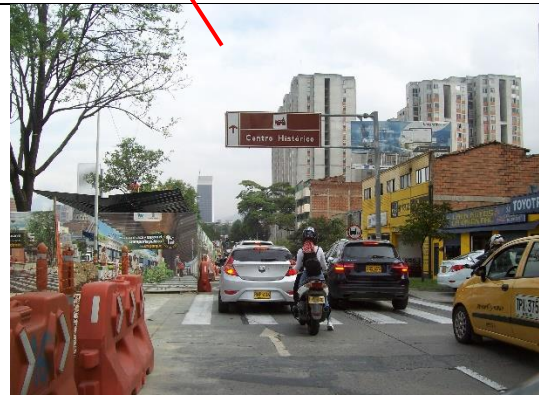
Ejecución de obras de estación de Metro Plus y Corredor verde
