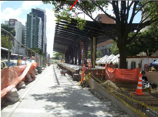
Cruce de la avenida Oriental con calle 56 Bolivia
