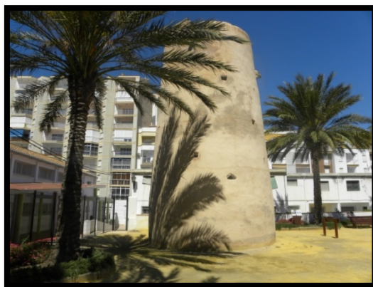
Figura número 563.- Fachada orientada al E de la torre de Torrenueva. Autor: José Ramón Sánchez Holgado.
