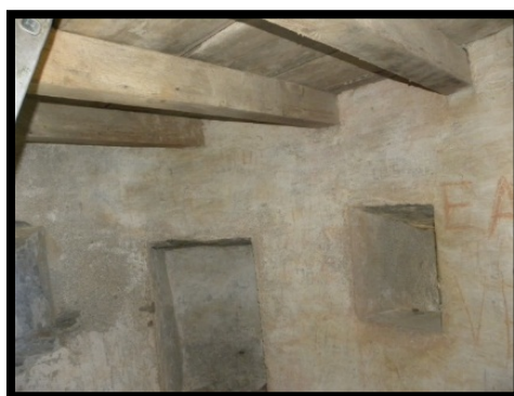
Figuras números 634 y 635.- Aspecto interior de la puerta-ventana, donde se aprecia en sus laterales y a media altura, unos orificios que pudieron ser empleados como refuerzos de la puerta mediante alamud o tranca y a la derecha, diferentes estancias separadas por superficies de maderas que servían de suelo o techo según los casos. Autor: José Ramón Sánchez Holgado.
