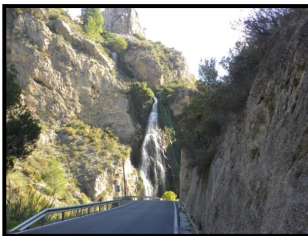
Figura número 206.- La carretera GR-4300, a la altura de la cascada de agua, del canal al río de la Toba (Término municipal Los Guájares). Autor: José Ramón Sánchez Holgado.
