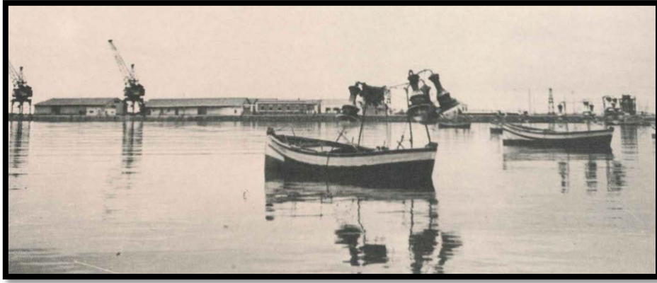
Figura número 225.- Vista parcial del muelle de poniente donde se aprecian las instalaciones del cable aéreo Dúrcal-Motril. Fuente: Tomada de la publicación de López Fernández. 684
