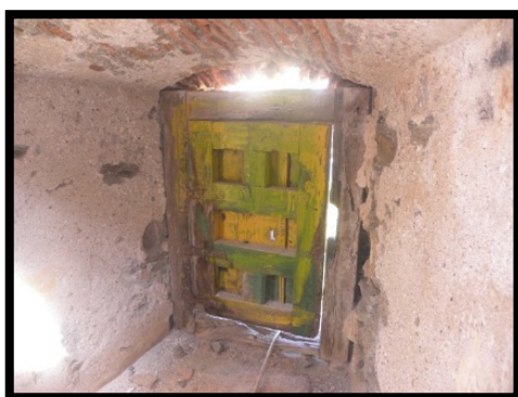
Figuras números 634 y 635.- Aspecto interior de la puerta-ventana, donde se aprecia en sus laterales y a media altura, unos orificios que pudieron ser empleados como refuerzos de la puerta mediante alamud o tranca y a la derecha, diferentes estancias separadas por superficies de maderas que servían de suelo o techo según los casos. Autor: José Ramón Sánchez Holgado.
