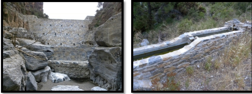
Figuras números 75 y 76.- Dique de contención situado en la rambla del Valenciano, término municipal de Sorvilán y pilar Tres Lindes, localizado en el monte público Pechos de La Galera, del término municipal de Los Guájares.
