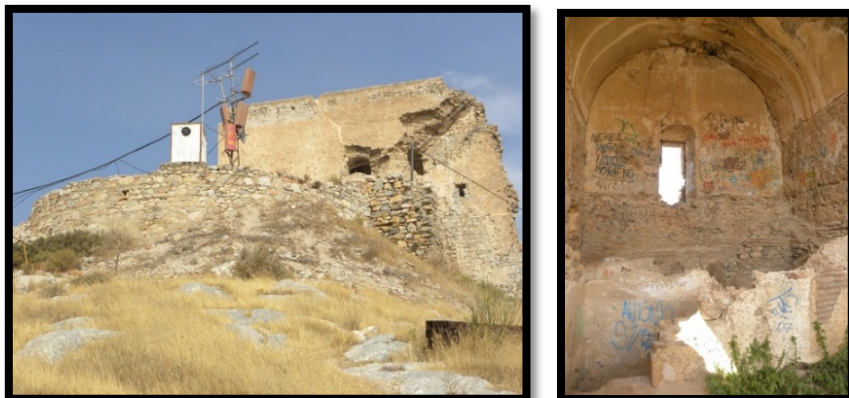
Figuras números 607 y 608.- Batería del castillo de Castell de Ferro y a la derecha, interior del castillo con techo abovedado. Autor: José Ramón Sánchez Holgado.
