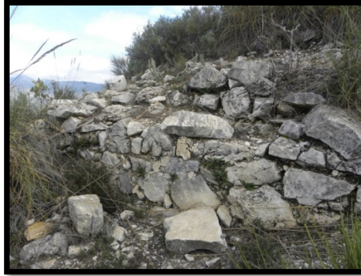
Figura número 654.- Estructura de obra maciza con acumulación de piedras. Autor: José Ramón Sánchez Holgado.
