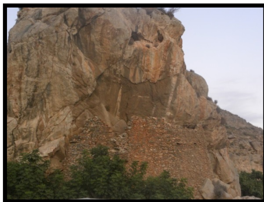
Figura número 584.- Fachada orientada al S del reducto fortificado de Calahonda. Autor: José Ramón Sánchez Holgado.
