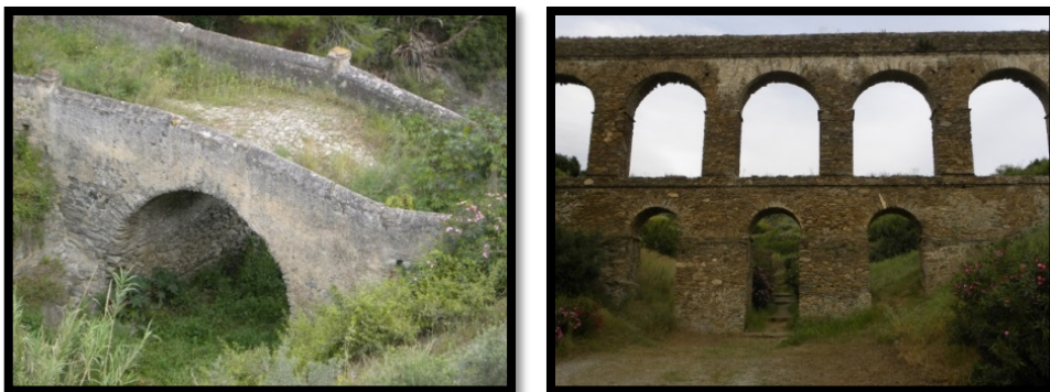
Figuras números 252 y 253.- El puente romano de Cotobro (Almuñécar) y a la derecha, un fragmento del acueducto de Almuñécar. Autor: José Ramón Sánchez Holgado.
