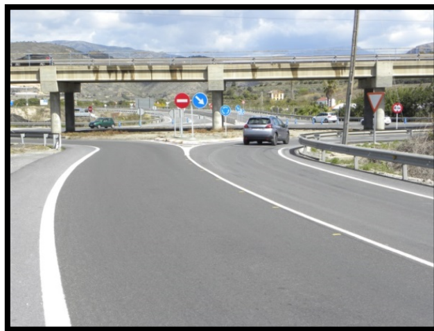
Figura número 204.- Intersección a desnivel de las carreteras N-340 y N-323, a la altura del término municipal de Motril. Autor: José Ramón Sánchez Holgado.
