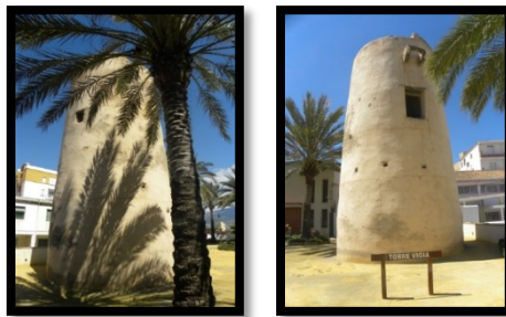
Figuras números 565 y 566.- Fachada orientada al SE y fachada orientada al N de la torre de Torrenueva. Autor: José Ramón Sánchez Holgado.
