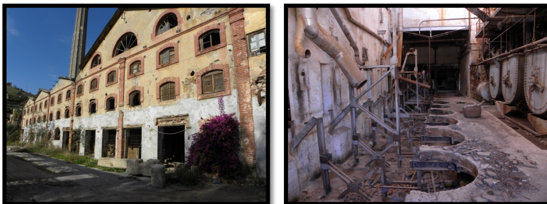
Figuras números 153y 154.- Estado actual de la fábrica de Nuestra Señora del Pilar en Motril (En proceso de rehabilitación). Autor: José Ramón Sánchez Holgado.
