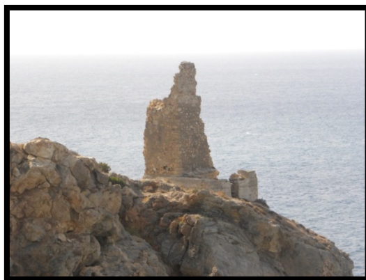
Figura número 596.- Fachada orientada al NO de la torre de la Rijana. Autor: José Ramón Sánchez Holgado.
