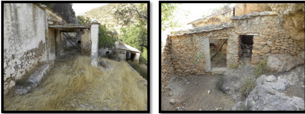
Figuras números 131 y 132.- Cortijos abandonados hace algunas décadas, en el término municipal de Lújar. Autor: José Ramón Sánchez Holgado. 510
