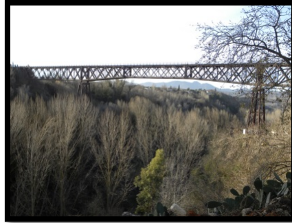
Figura número 210.- Estado actual del puente ferroviario metálico, conocido como punte de lata y que atraviesa el río Dúrcal, a la entrada a su núcleo poblacional (comarca Valle del Lecrín) y donde se alcanzaba la finalización del trayecto de la conexión viaria Padul-Dúrcal. Autor: José Ramón Sánchez Holgado.
