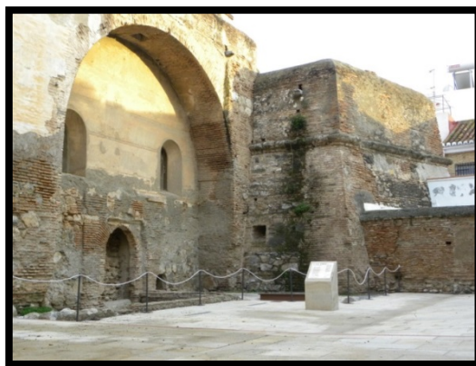
Figura número 560.- Fachada orientada al NE de la torre de Vela. Autor: José Ramón Sánchez Holgado.
