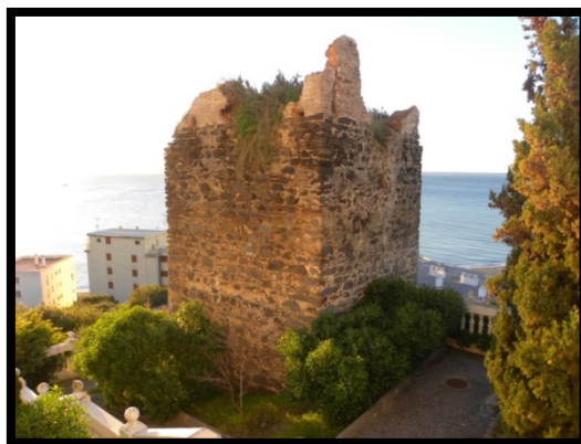
Figura número 527.- Fachada orientada al NE de la torre del Granizo. Autor: José Ramón Sánchez Holgado.
