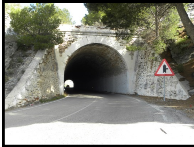
Figura número 205.- Túnel de la Gorgoracha, situado en la carretera A-4133 y según inscripción que porta en la parte superior de su arco, construido en 1860, reinando Isabel II. Autor: José Ramón Sánchez Holgado.
