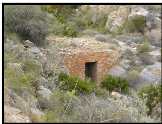
Figura número 350.- Fachada del refugio antiaéreo con una puerta de acceso orientada al S. Autor: José Ramón Sánchez Holgado.
