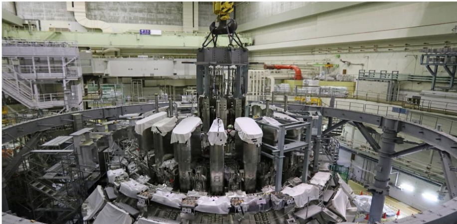
Figura 3.13. Instalación del solenoide central de 4 módulos y 100 toneladas de peso [URL, 48].
