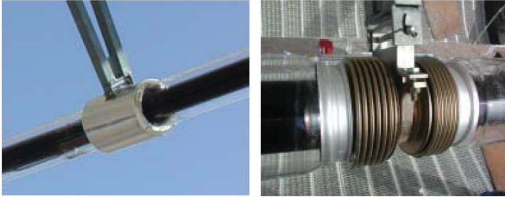
Fig. 2.21. Imágenes de los soportes del colector tipo LS-2 [49]
