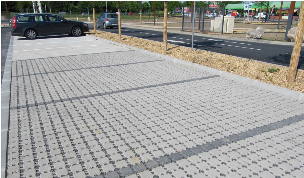
Fig.2.72. Banda de aparcamiento construida con adoquín drenante
