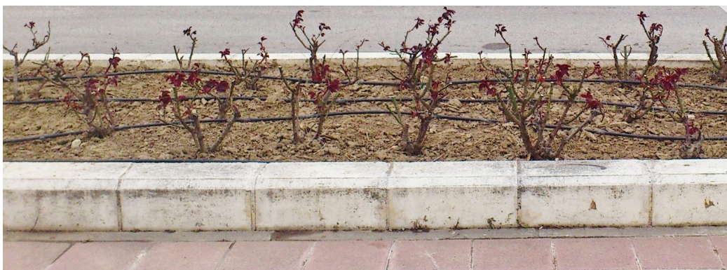
Fig.2.66. Jardinera configurada con encintado de piezas de bordillo. Riego por goteo.
