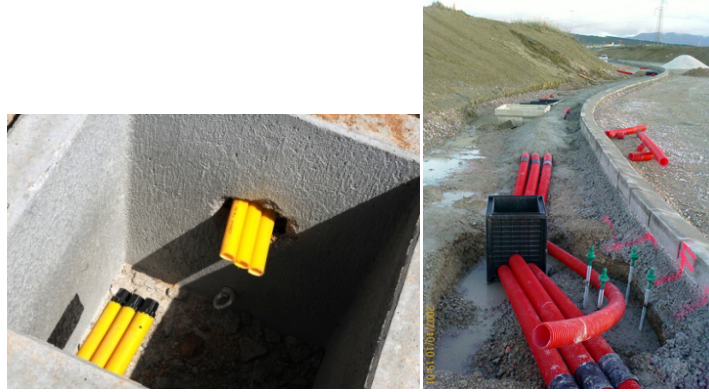
Fig.2.50. Infraestructuras para red de telecomunicación
