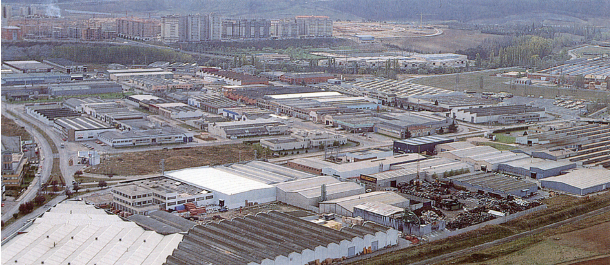
Fig.2.17. Polígono Industrial de Landaben. Pamplona.
