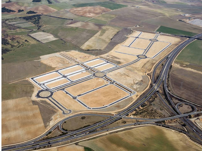
Fig. 2.6. Vista aérea infraestructuras Parque logístico industrial de Tordesillas
