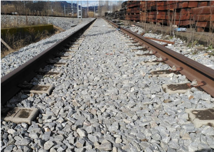
Figura 3.10. Vista del tendido de vía con traviesa de hormigón. Elaboración propia.
