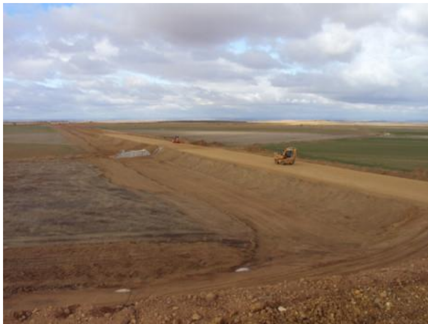
Figura 3.17. Instalación de la capa de forma para el posterior vertido de la capa de balasto. Elaboración propia.
