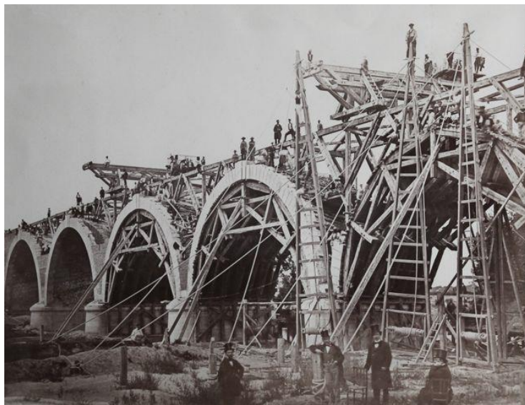
Figura 3.40. Proceso de construcción del Puente de los Franceses (Fontanella, 1999).
