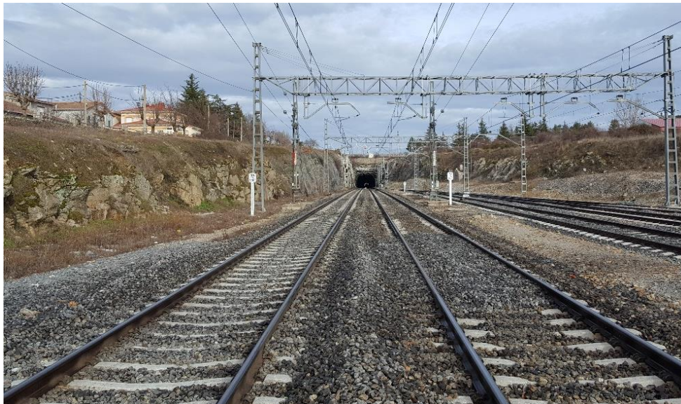
Figura 3.15. Vía sobre balasto. Elaboración propia.
