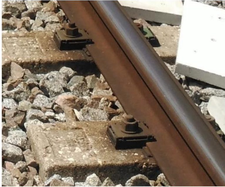
Figura 3.29. Sujeción tipo Nabla. Elaboración propia.
