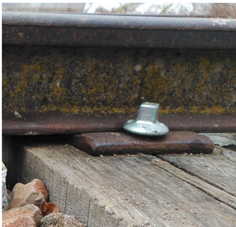
Figura 3.28. Detalle de una sujeción de tirafondos a una traviesa de madera. Elaboración propia.
