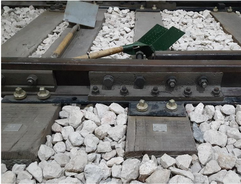
Figura 3.35. Brida de unión entre fragmentos de carril. Elaboración propia.
