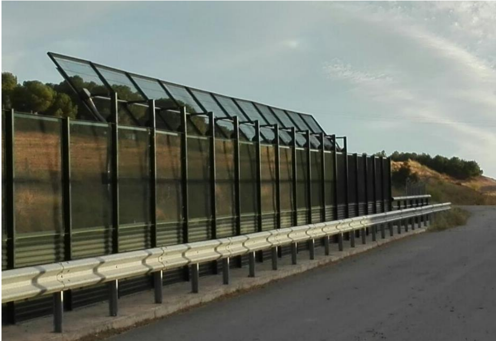
Figura 3.44. Ubicación de los detectores de caídas de objetos. Elaboración propia.
