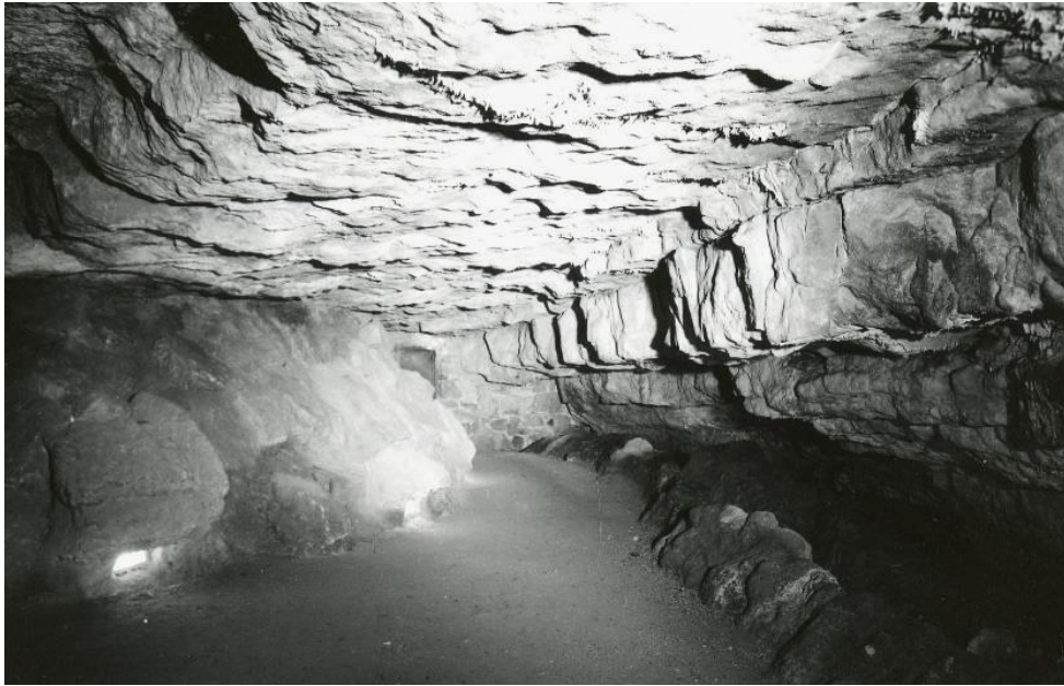
Figura 30: Instalación de luz eléctrica fluorescente en la Cueva de Altamira (Lasheras, et al , 2014).
