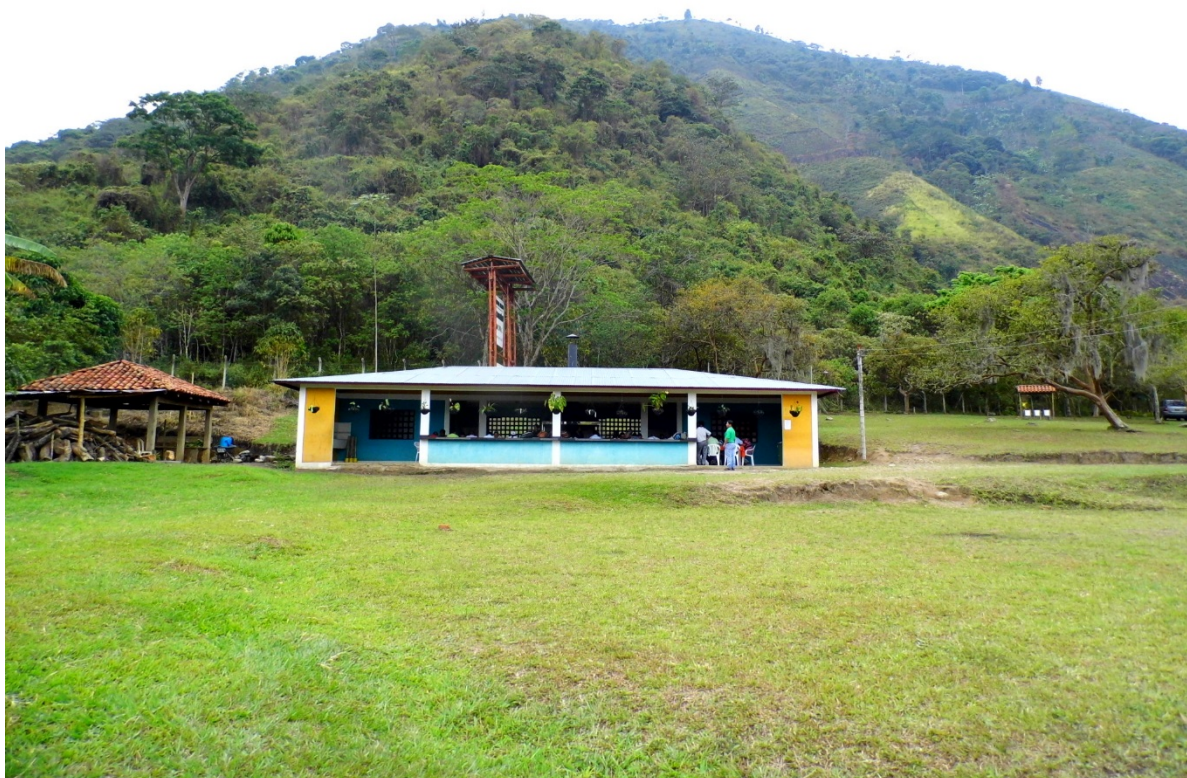
Foto N° 25. Restaurante escolar del IDEBIC, Florida ( Valle)
