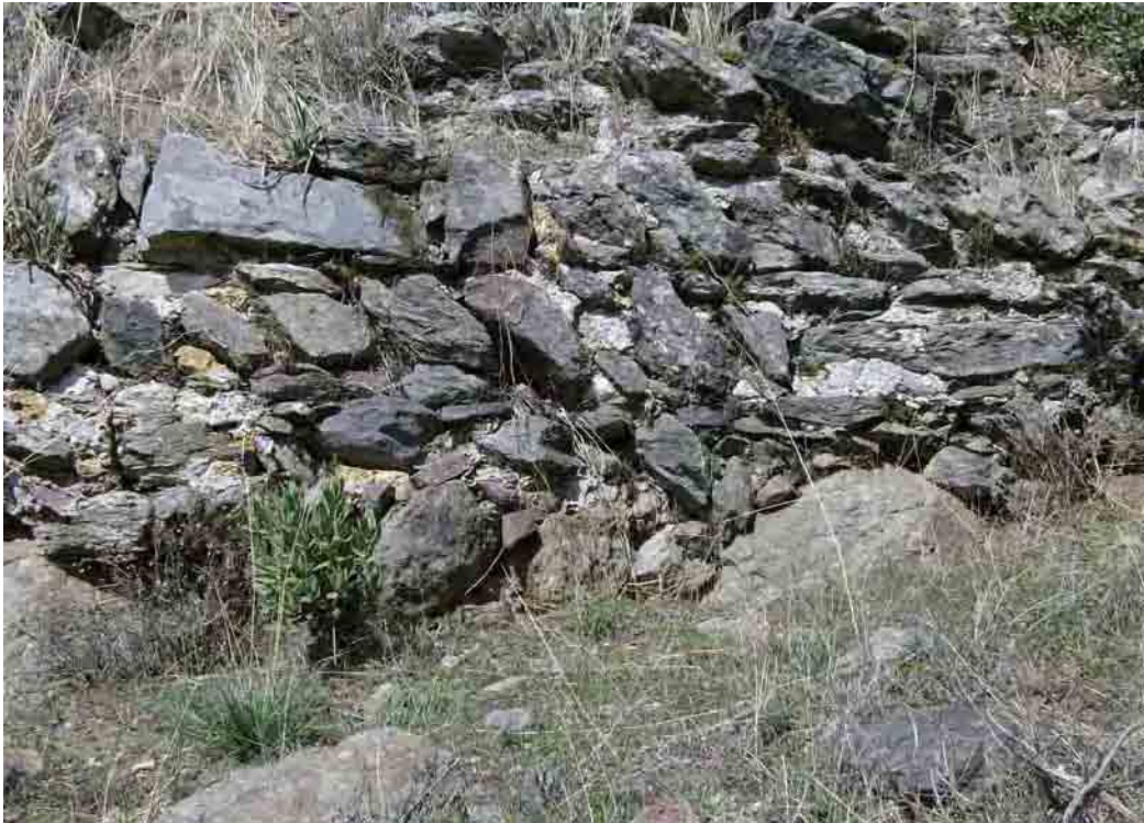
Detalle de la fábrica, próxima al opus spigatum , del lienzo Sureste de la fortificación.
