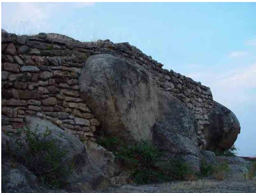
Reaprovechamiento del roquedo para el levantamiento de la torre fortificada
