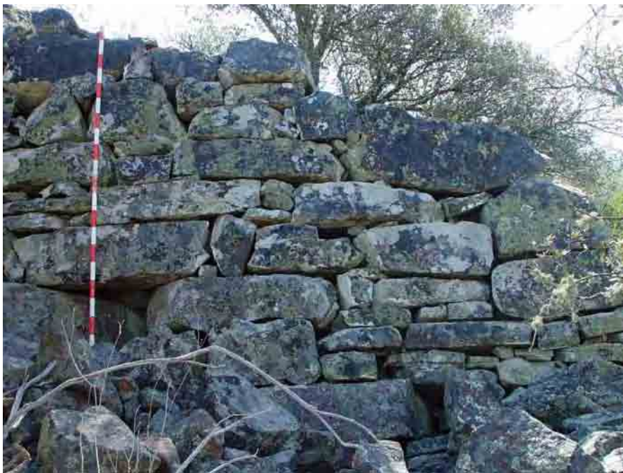
Restos de fábrica de la muralla levantada en seco (fotos: Gibello, V.)
