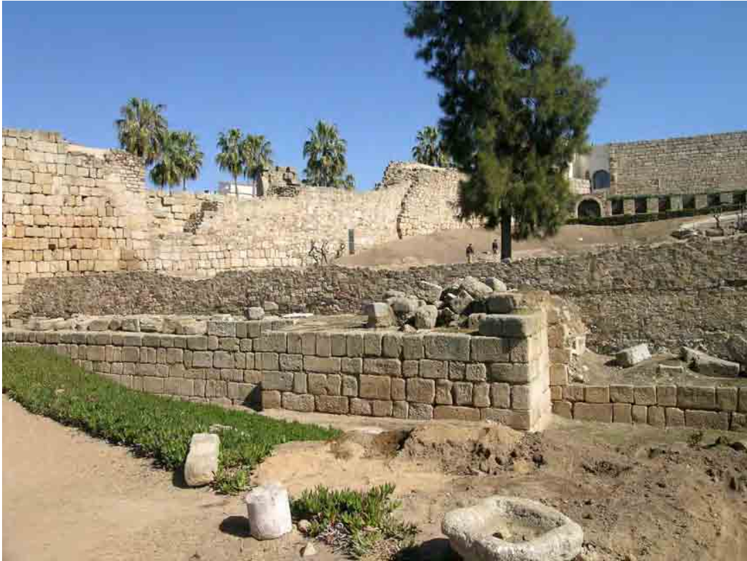
Fig. 44. Forramiento de sillares del siglo V en el tramo de muralla ubicada en el interior de la alcazaba árabe.
