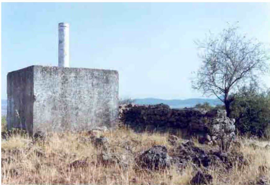
Restos de la atalaya (burÿ), reaprovechado en la actualidad su interior para fijar un vértice geodésico (foto: Alba Calzado)
