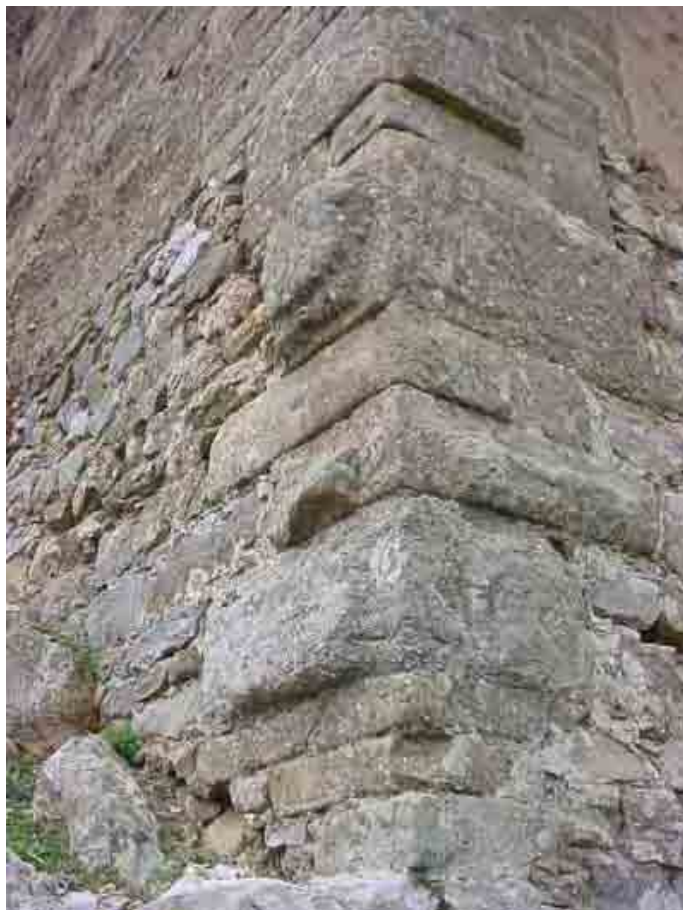
Detalle de fábricas y reutilización de sillares romanos en una esquina del recinto amurallado (Foto © Juan Gil)
