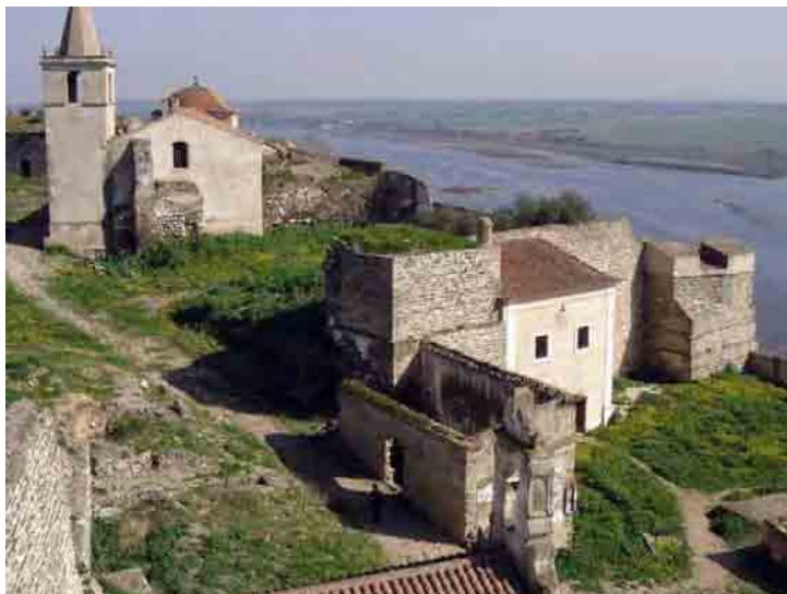
Perspectiva del interior de la fortificación actual, que reaprovecha parte de la obra emiral
