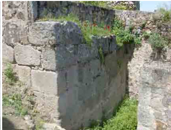
Acceso al recinto de época emiral
