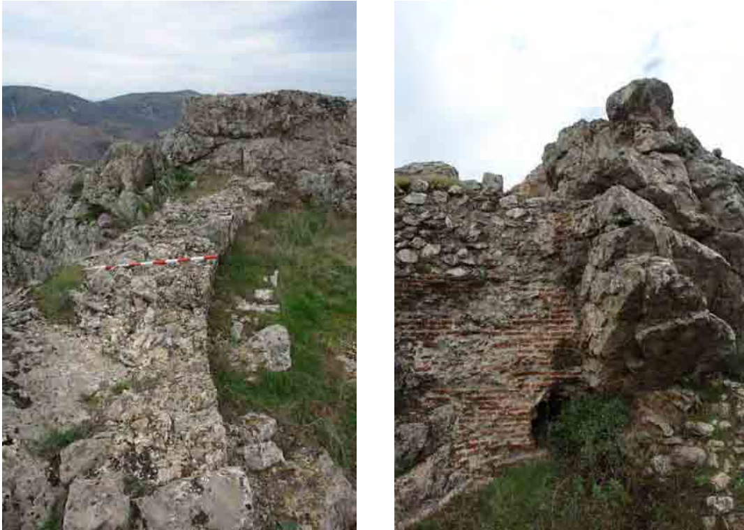
Cerramiento de la muralla aprovechando el desnivel del terreno y detalle del aljibe
