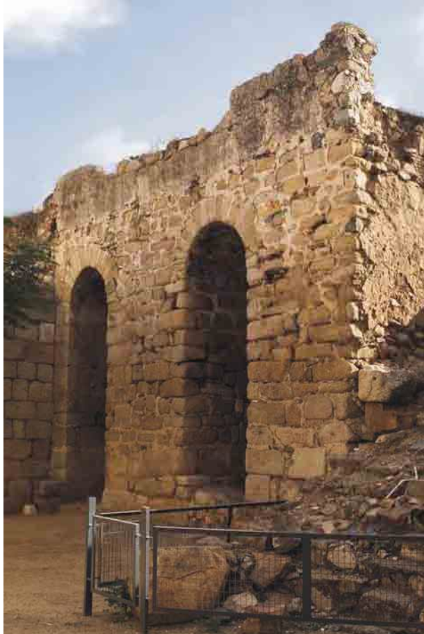
Fig. 48. Torre albarrana de época califal en el tramo de muralla de la C/ Obispo Masona.
