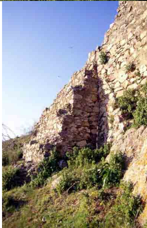
Panorámica de la Serena desde el yacimiento y lienzo de un muro con torre en escarpa
