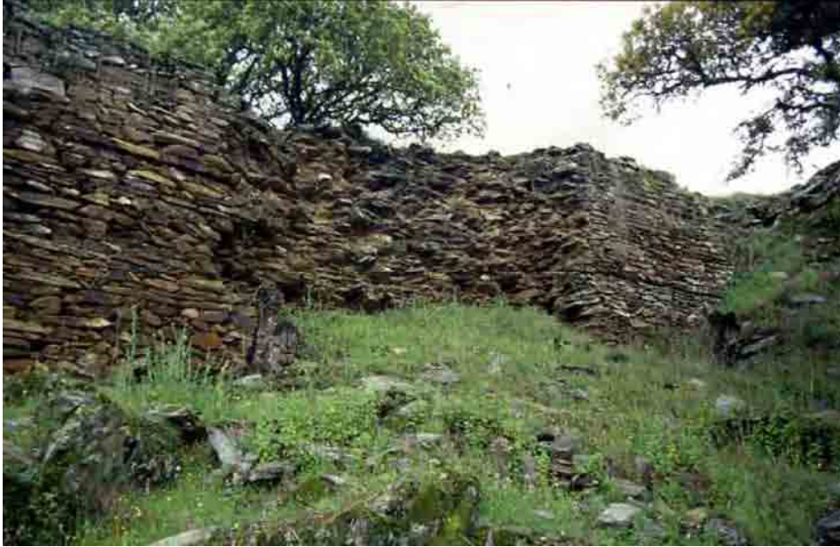
Lienzo del recinto amurallado con torres sobresalientes cuadrangulares trabadas en seco
