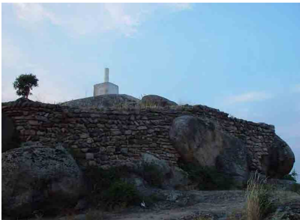
Restos de la fortificación con su característica fábrica a sardinel (Fotos: Gibello, V.)
