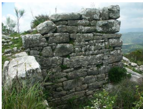
Fig. 159.- Bastión Suroeste de la muralla de Lacipo .
