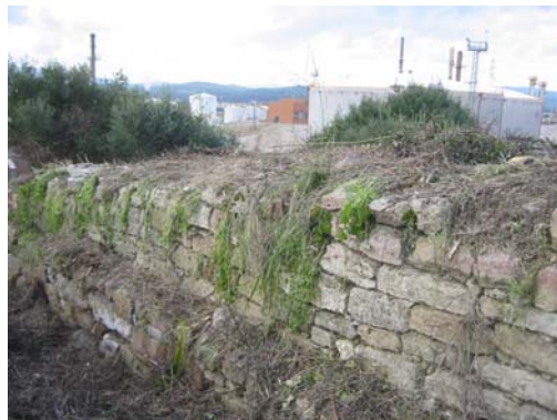
Fig. 144.- Muralla romana en el sector Noroeste
